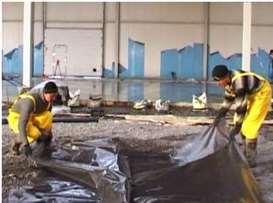
Рисунок 2 – Устройство гидроизоляции.
