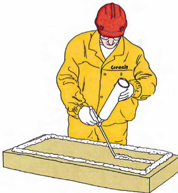
Рисунок 12 – Нанесение полиуретанового клея Ceresit СТ 84
