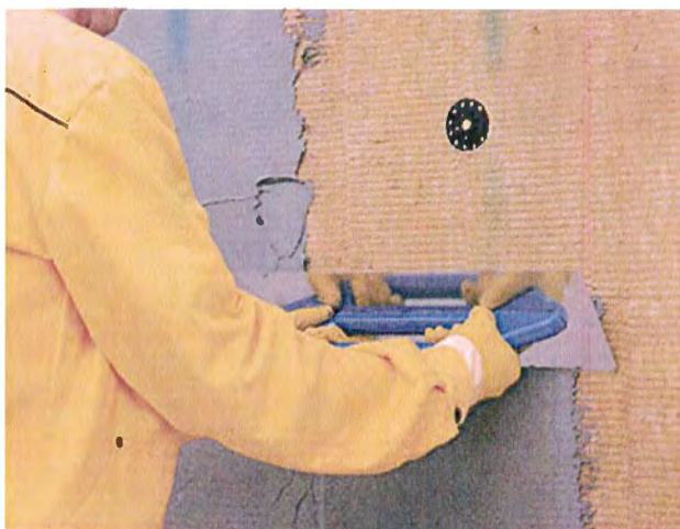
Рисунок 29 – Нанесение клеевого состава на теплоизоляционный слой
