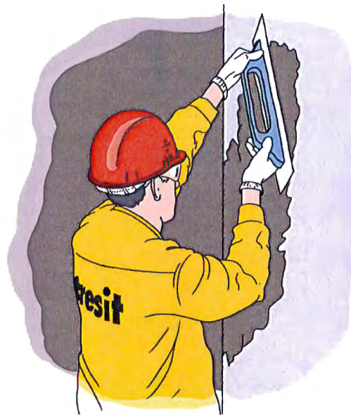
Рисунок 6 – Нанесение выравнивающей смеси на поверхность
