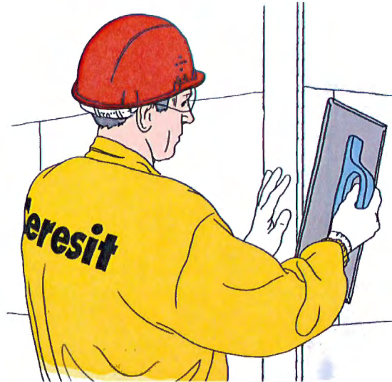
Рисунок 16 – Выравнивание теплоизоляционных плит шлифовальной теркой
