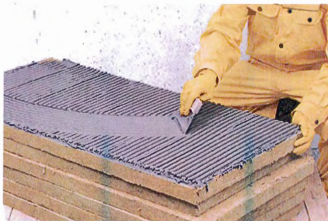
Рисунок 11 – Нанесение клеевого состава методом сплошного приклеивания
