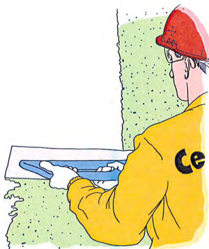
Рисунок 34 – Нанесение декоративной штукатурки
