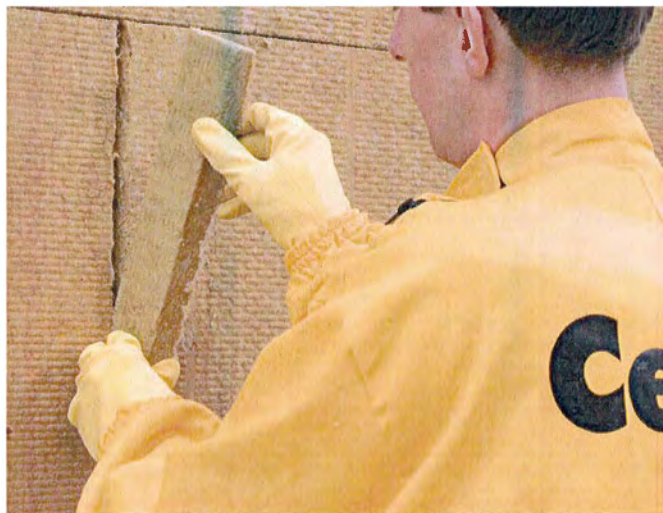
Рисунок 17 – Заделка щелей между теплоизоляционными плитами
