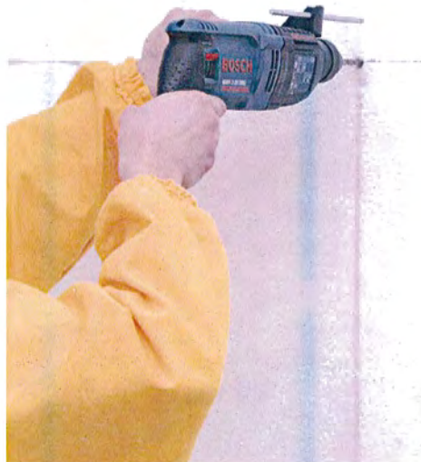
Рисунок 23 – Сверление отверстий электроперфоратором
