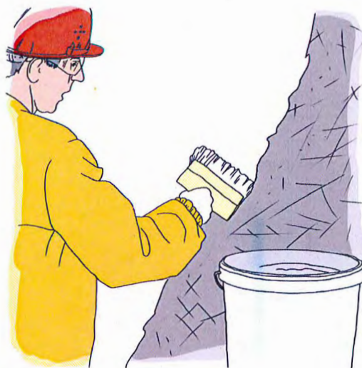
Рисунок 33 – Грунтование армированного слоя
