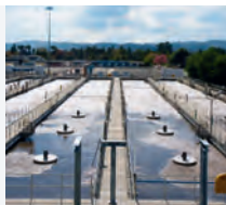
Очистка сточных вод
