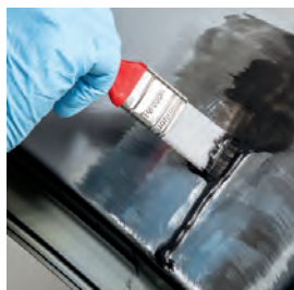
Нанесение изолирующего защитного слоя с помощью TEROSON EP 5055
