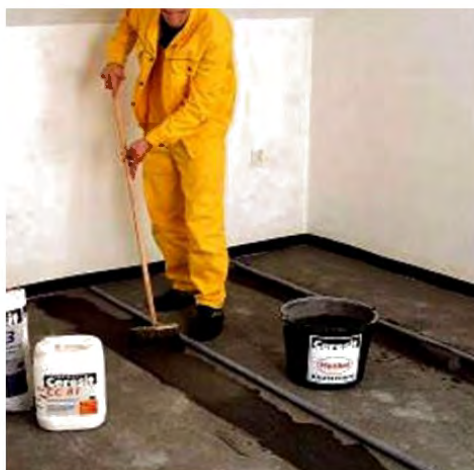
Рисунок 10 – Нанесение контактного слоя
