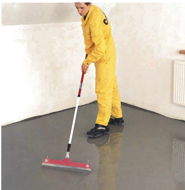
Рисунок 14 – Распределение смеси по поверхности основания
