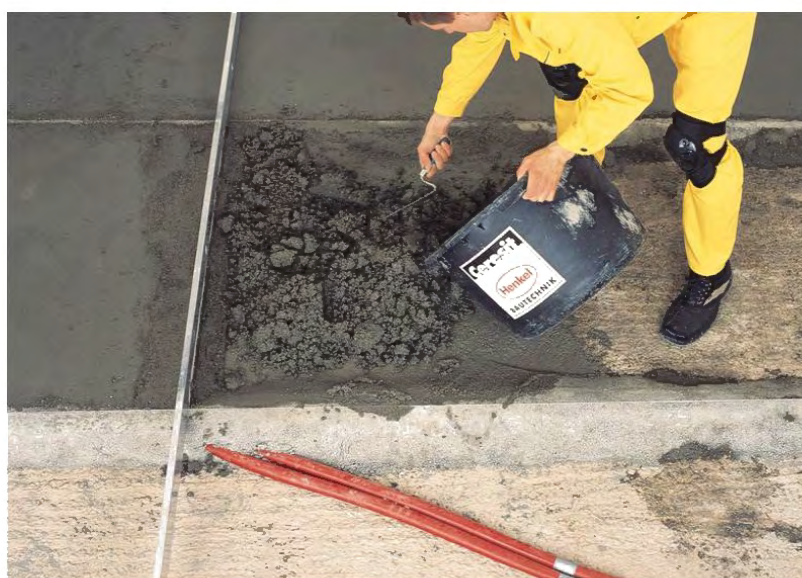
а) распределение смеси между маячными рейками с помощью кельмы
