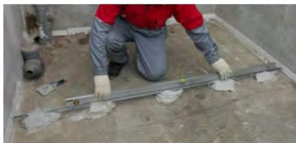
Рисунок 8 – Установка маячных реек на маяки из смеси
