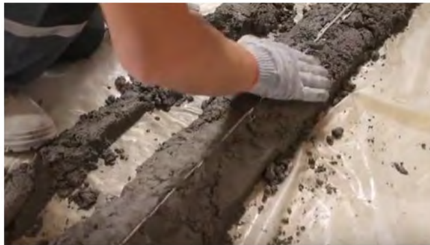
Рисунок 9 – Распределение раствора под маяками
