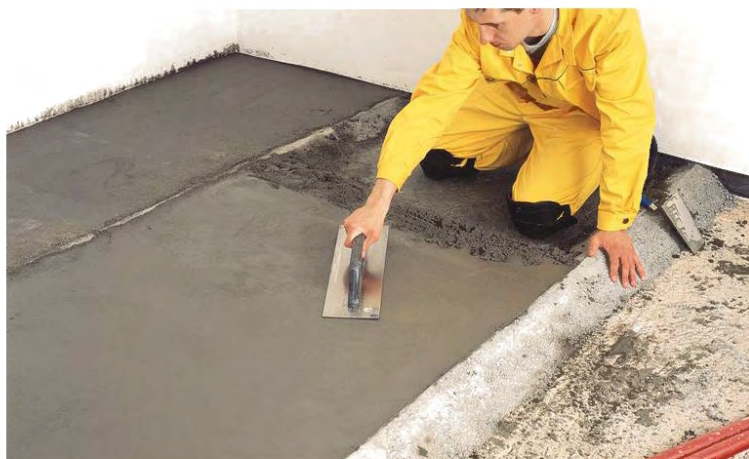
Рисунок 12 – Разравнивание смеси теркой
