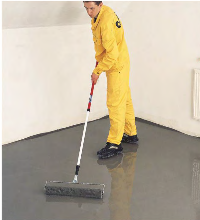
Рисунок 15 – Деаэрация уложенной смеси игольчатым валиком
