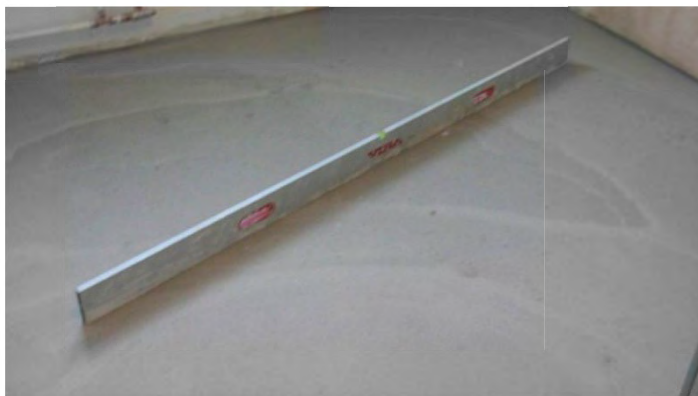
Рисунок 17 – Контроль ровности поверхности
