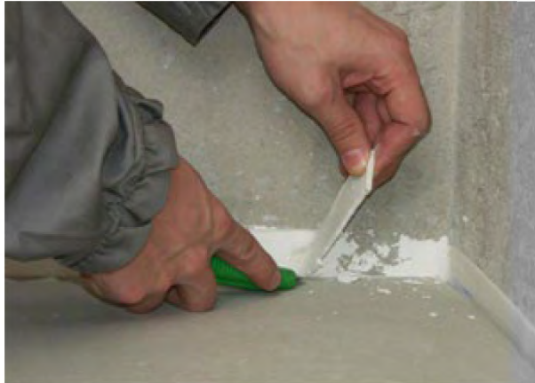
Рисунок 16 – Срезка демпферной ленты
