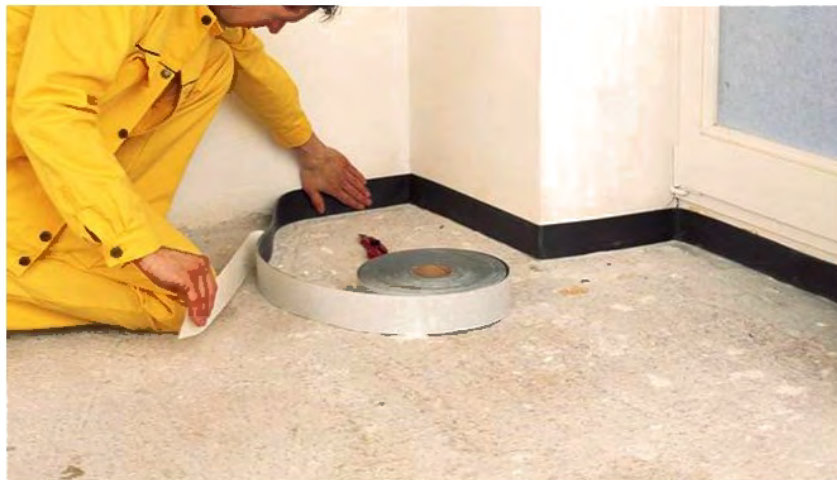
Рисунок 2 – Устройство изоляционного шва из демпферной ленты
