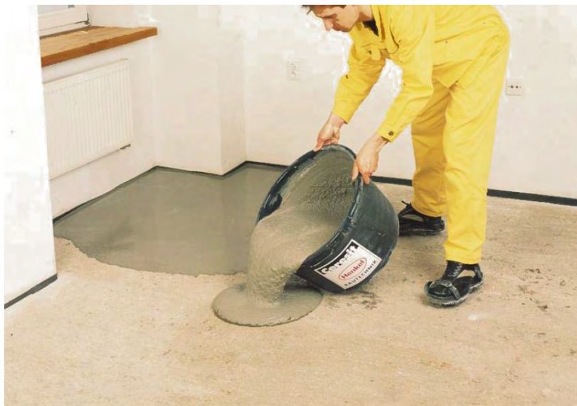
Рисунок 13 – Укладка самонивелирующей смеси
