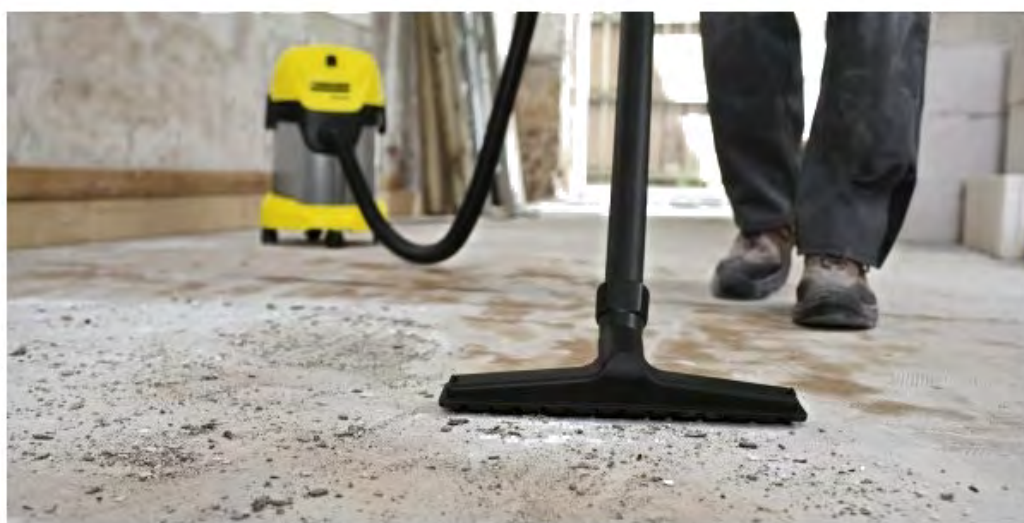
Рисунок 6 – Очистка основания с помощью пылесоса
