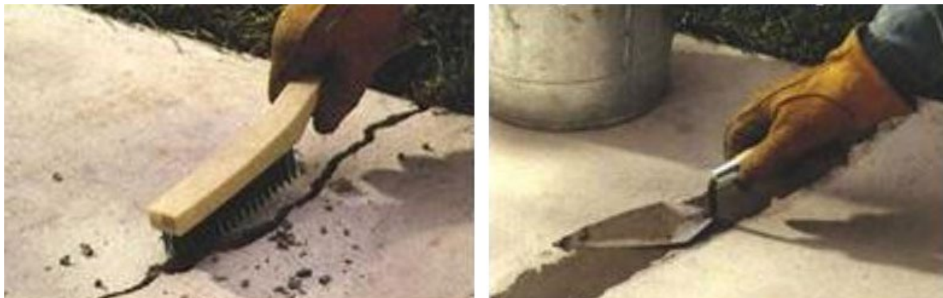
а – Очистка расшитой трещины б – Заполнение трещины
