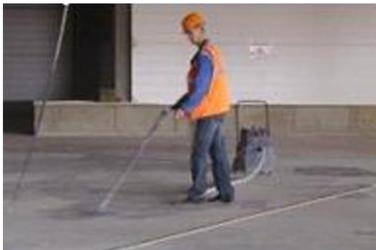
Рисунок 4.3 – Обеспыливание поверхности основания при помощи промышленного пылесоса
