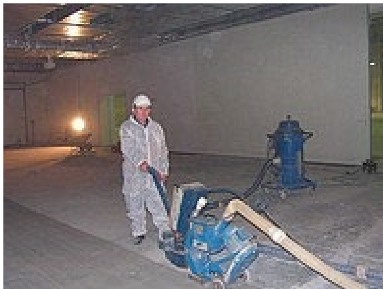
Рисунок 4.2 – Дробеструйная обработка бетонного основания
