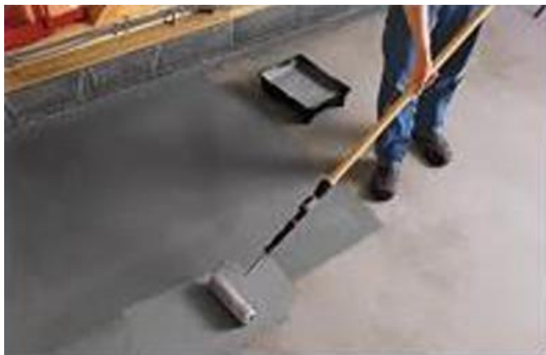
Рисунок 4.5 – Окраска поверхности основания
