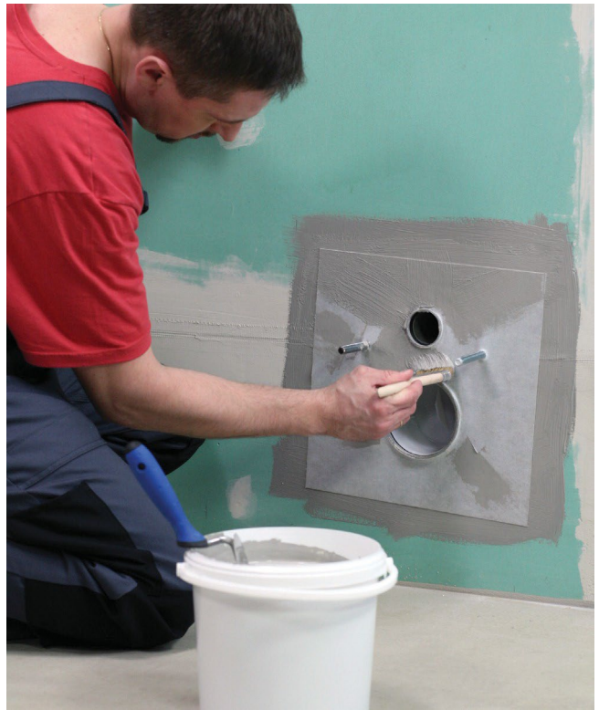
Težina lijepljenja brtvene trake ili tehničkog flisa max. 60 g/m 2 za perforacije cijevi
