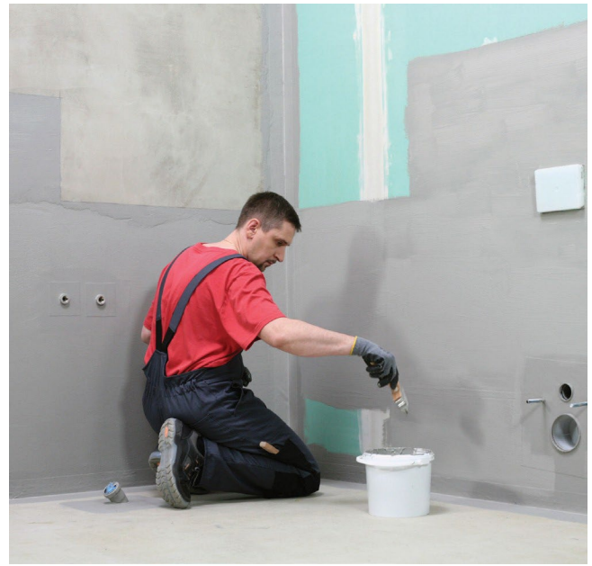
Nanošenje četkom prvog i drugog sloja izolacije.
