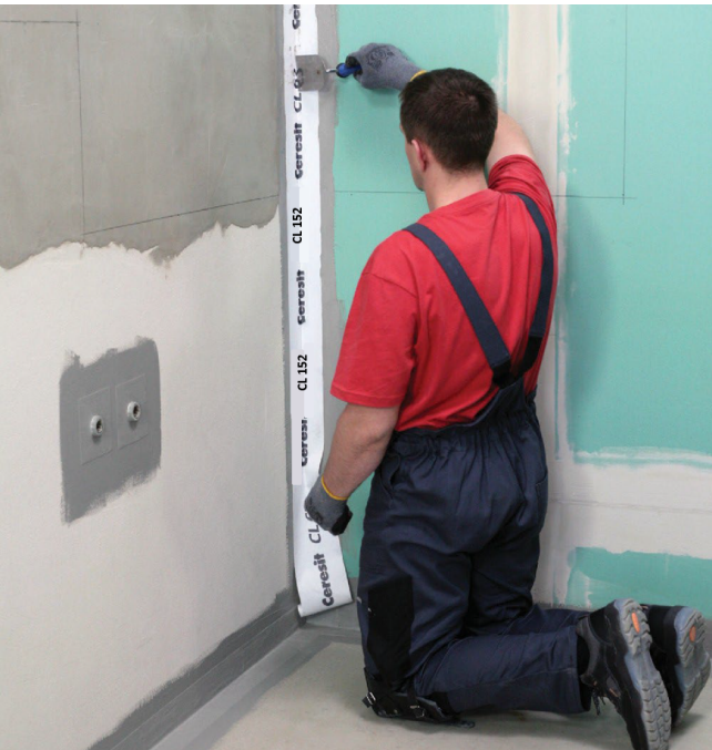
Lijepljenje brtvene trake u okomite uglove.
