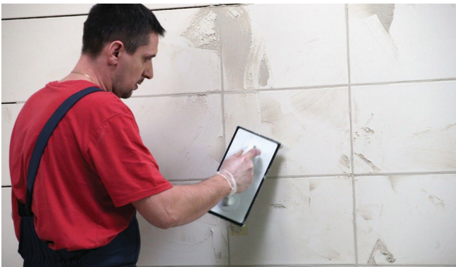
Pažljivo ispunite fuge između pločica sa CE 40 masom za fugiranje
