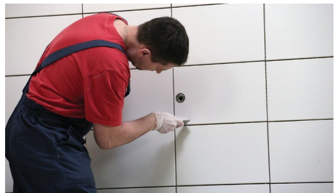
Čišćenje fuga pločica prije fugiranja
