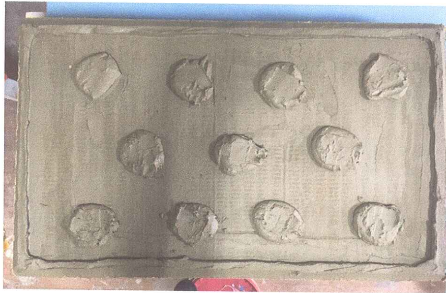
Рисунок 4 – Наносяться маячки (ляпухи) та полоса за периметром
