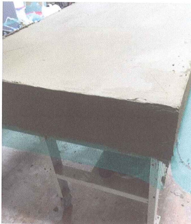
Рисунок 5 – Приклеювання, встановлення дюбелів, нанесення захисного шару з сіткою.
