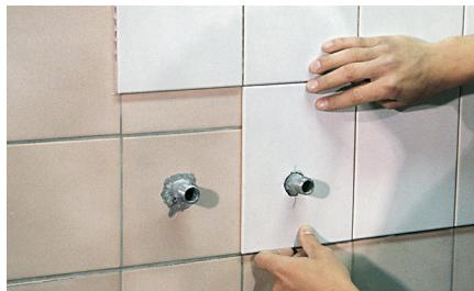
**Sistem polaganja „ploščica na ploščico“ se uporablja tako za notranje kot za zunanje površine.**
