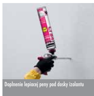
Lepenie na už zateplený podklad
