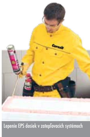
Vyplňanie škár pri spájaní dosiek izolantu
