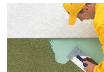
Nanášanie mozaikovej omietky na podklad ošetrený základným náterom Ceresit CT 16.
