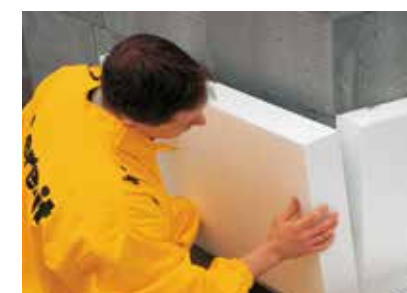
Lepení izolačních desek z polystyrénu.
