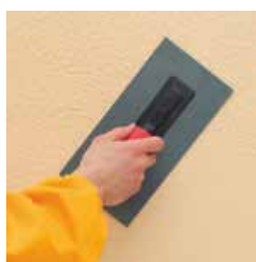
Vytvorenie štruktúry omietky pomocou plastového hladidla.
