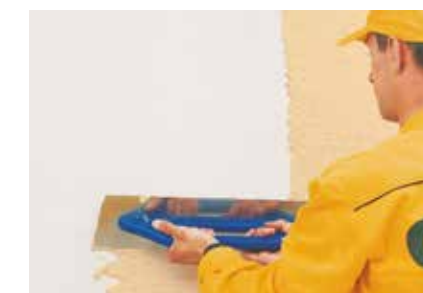
Nanášanie omietok pomocou nerezového hladidla.
