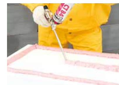
Nanášání polyuretanového lepidla CT 84 Express na polystyrénovou izolační desku.
