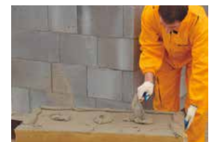
Nanášání lepiče malty na izolační desku z minerální vlny.
