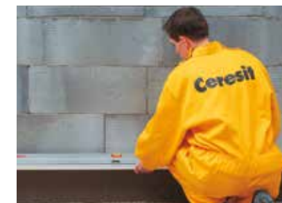
Upevňování soklových profilů na nerovný podklad.
