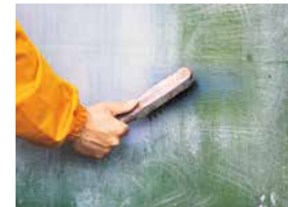
Příprava podkladu pomocí drátěné kefy nebo otryskáním.
