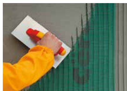
Celoplošná aplikácia výstužnej vrstvy.
