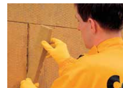
Plnění případných mezer mezi izolačními deskami.
