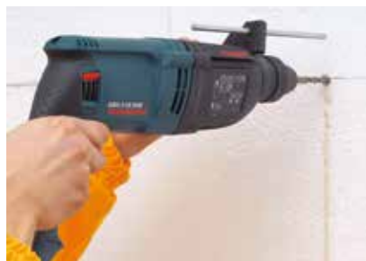
Kotvenie polystyrénových dosiek.
