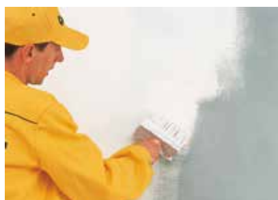
Nanášanie základného náteru (nie je nutný v prípade výstužnej vrstvy vytvorenej pomocou malty Ceresit CT 87).
