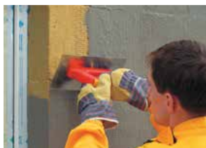
Aplikácia prvej (adhéznej) vrstvy - pri izolácii z minerálnej vlny.
