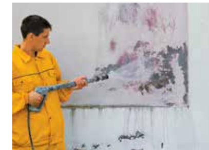
Příprava podkladu pomocí drátěné kefy nebo otryskáním.
