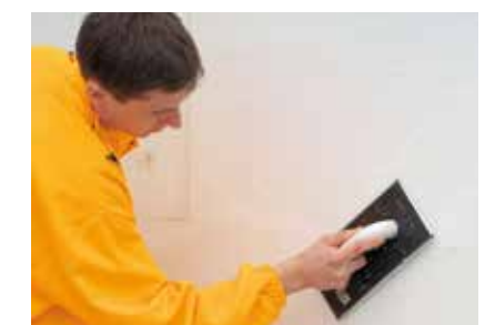
Vyrovňování povrchu izolačních desek.
