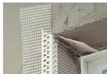
Aplikácia rohových líšt, diagonálnych pásov, dilatačných profilov a pod.
