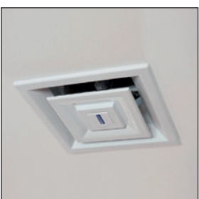
Upevňovanie ventilačných mriežok
