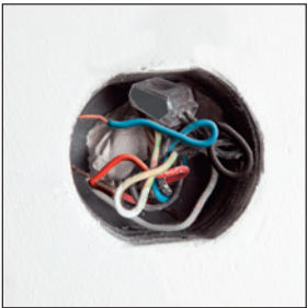
Fixáciu inštalačných skríň
