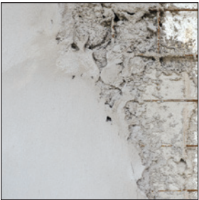
Opravy železobetónových prvkov
