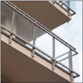
Fixácia zábradlia na balkónoch
