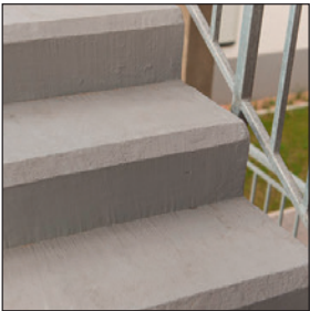
Opravy betónových prvkov (hrany schodov)
