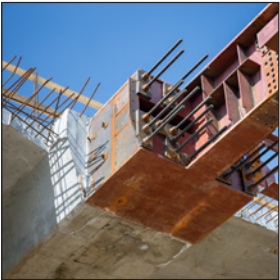
Ukotvenie stĺpov a ložísk mostov
