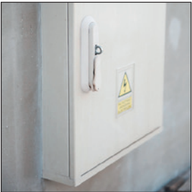
Fixáciu inštalačných skríň
