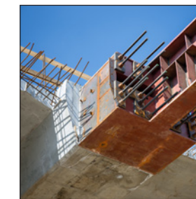
Ukotvenie stĺpov a ložísk mostov
