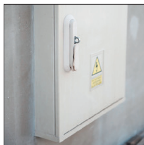
Fixáciu inštalačných skríň
