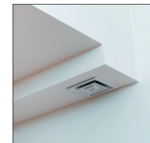
Vypĺňanie trhlín a prasklín v stenách a stropoch
