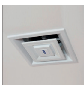
Upevňovanie ventilačných mriežok
