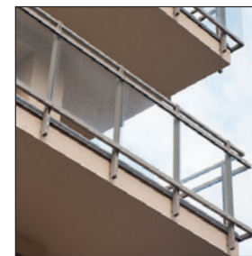
Fixácia zábradlia na balkónoch
