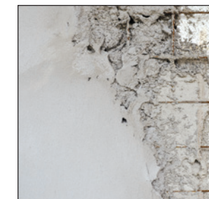
Opravy železobetónových prvkov
