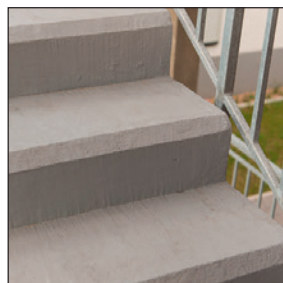
Opravy betónových prvkov (hrany schodov)
