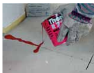
Umplerea fisurilor cu rășină epoxidică
