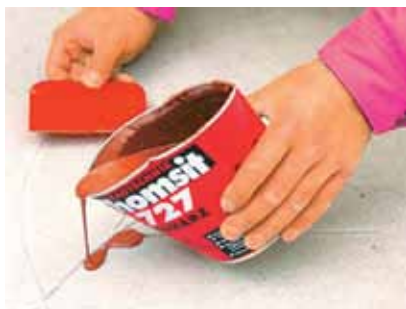
Umplerea fisurilor cu rășină epoxidică
