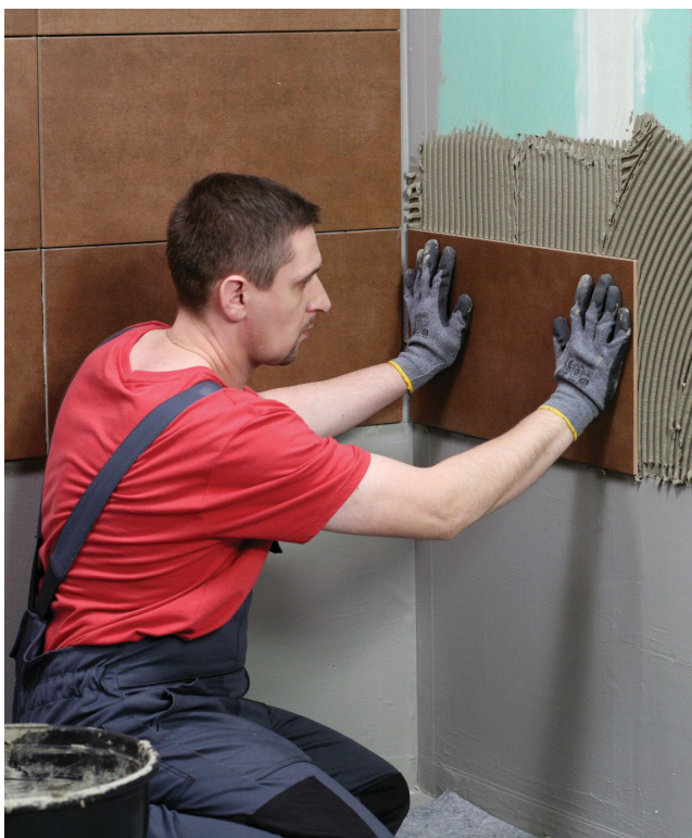
Po 4 urah lahko začnete z lepljenjem ploščic
