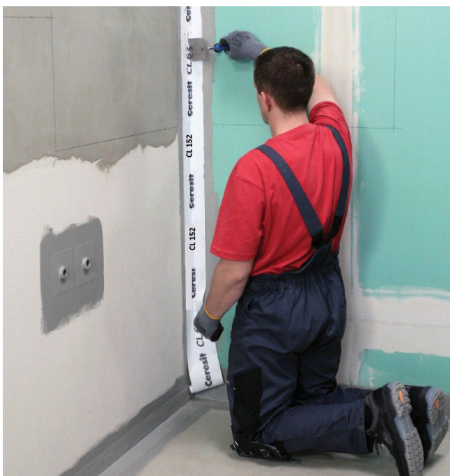
Lepjenje tesnilnega traku v vertikalnih kotih.
