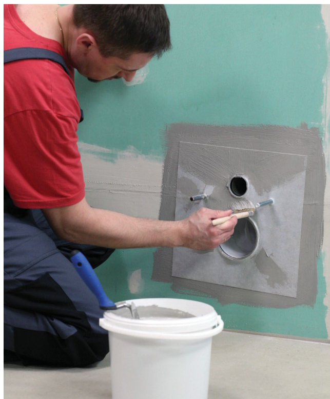
Lepjenje tesnilnega traku ali tehničnega flisa teže max. 60 g/m 2 pri prebojih cevi
