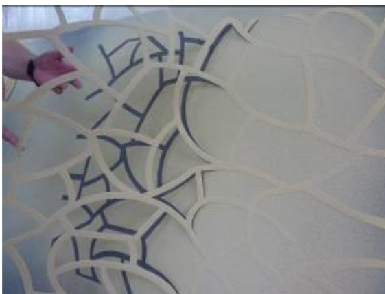
Рисунок 4.19 - Шаг 3. Снятие трафарета по свежему штукатурному составу.
