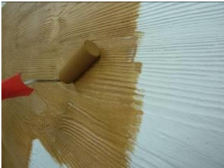
Рисунок 4.16 – Пример нанесения пропитки валиком.
