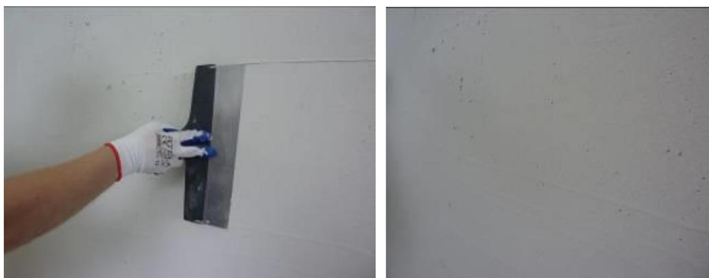
Рисунок 4.9. - Шаг 3. Разравнивание состава шпателем.
