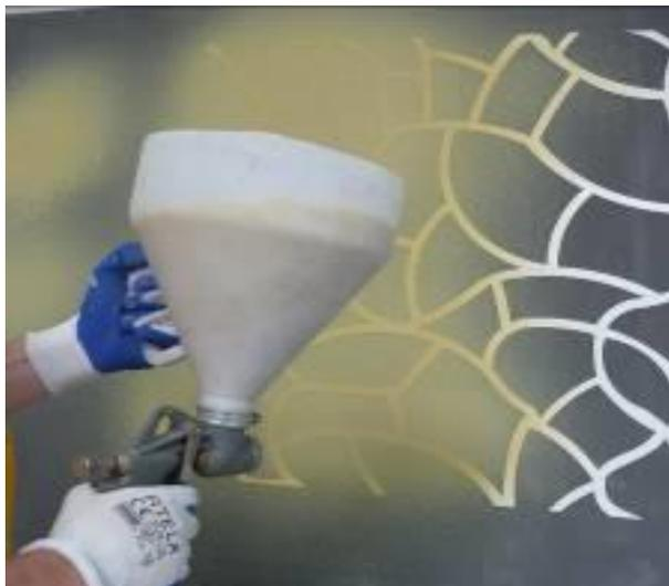
Рисунок 4.2 – Машинный способ нанесения штукатурок
