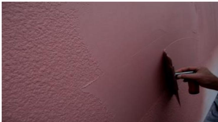
Рисунок 4.5 – Ручной способ нанесения штукатурок
