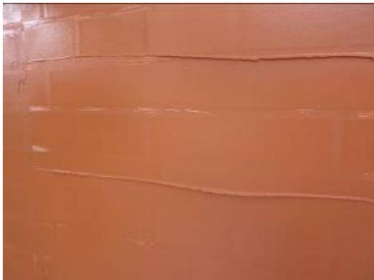
Рисунок 4.23 - Шаг 3. Загладить состав при помощи металлической гладилки.
