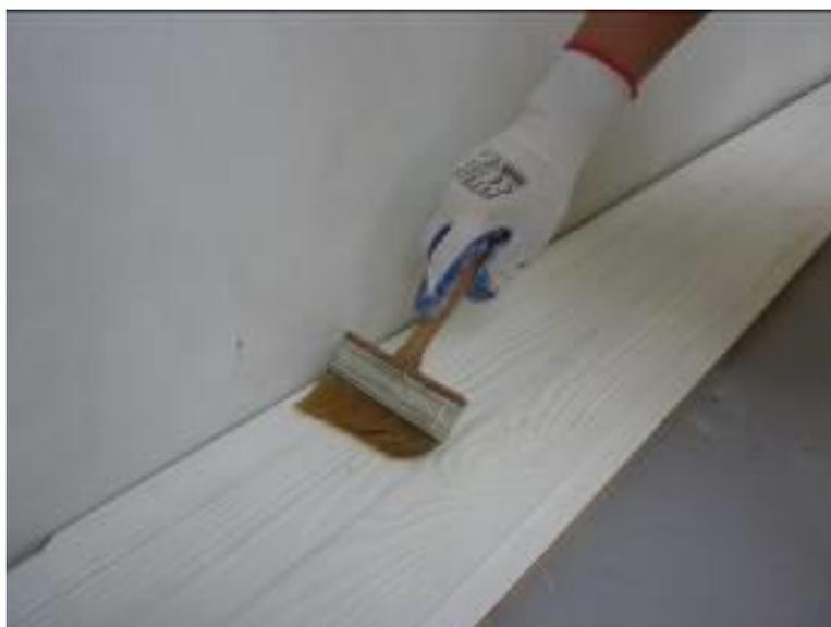
Рисунок 4.12 - Шаг 5. Подготовка матрицы «под дерево» к применению – обработка при помощи кисти-макловицы антиадгезионной смазкой Ceresit CT 722.
