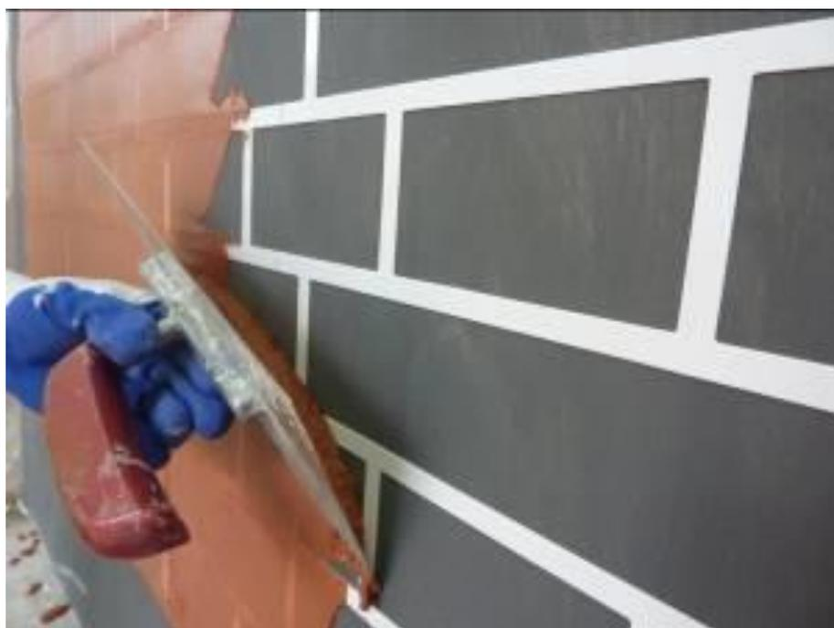
Рисунок 4.22 - Шаг 2. Нанесение состава при помощи металлической гладилки.
