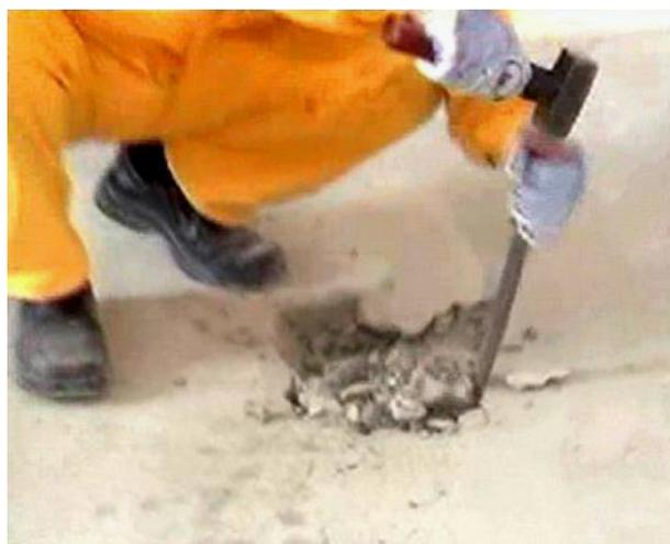
Рисунок 6.29 – Удаление непрочного слоя основания
