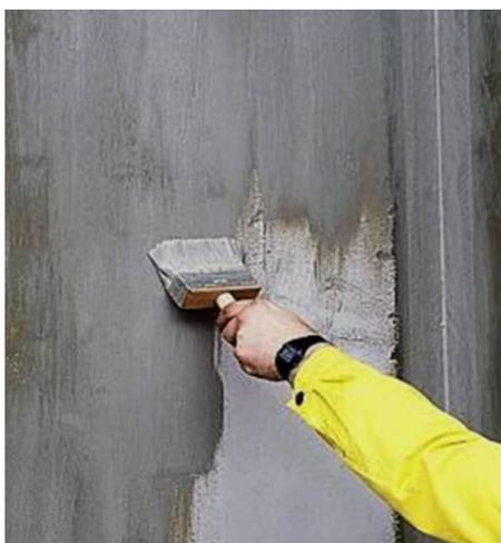
Рисунок 6.35 – Нанесение первого слоя гидроизоляционного состава Ceresit CR 65 или Ceresit CR 166
