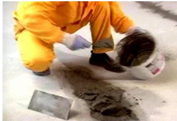
Рисунок 6.31 – Пример заделки выбоин и впадин составом Ceresit CN 83
