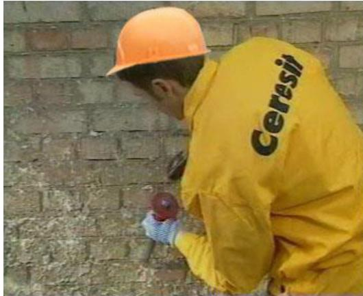
Рисунок 6.23 – Очистка поверхности зубилом и молотком
