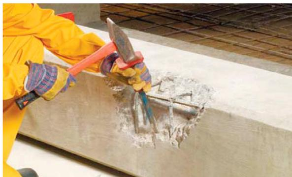
Рисунок 6.1 – Удаление слоев бетона, утративших сцепление с основанием
