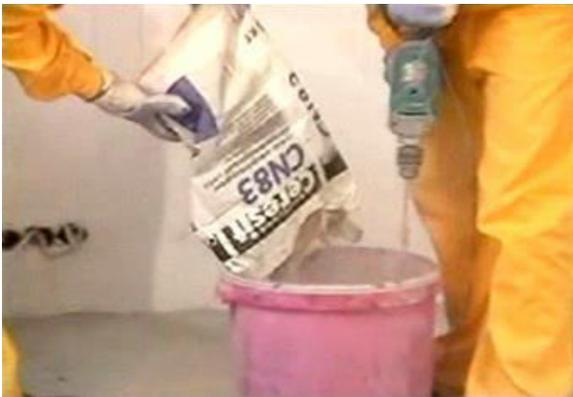
Рисунок 6.30 – Пример приготовления состава Ceresit CN 83 с адгезионной добавкой Ceresit CC 81
