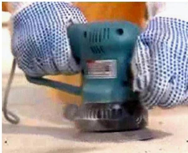
Рисунок 6.28 – Удаление пятен от битума, красок шлифовальной машиной
