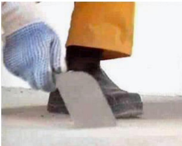
Рисунок 6.27 – Удаление цементного молочка шпателем
