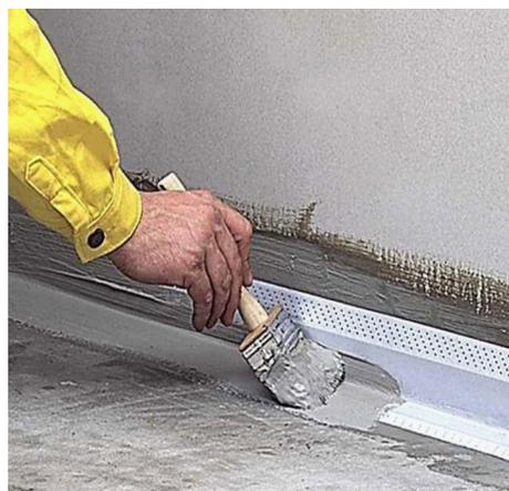
*б*) – нанесение второго слоя гидроизоляционного состава
