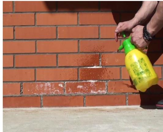
Рисунок 6.26 – Удаление солевых отложений преобразователем солей
