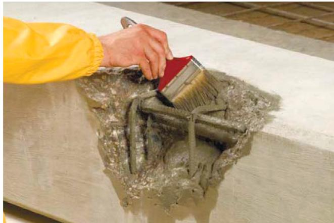
Рисунок 6.4 – Устройство контактного слоя Ceresit CD 30
