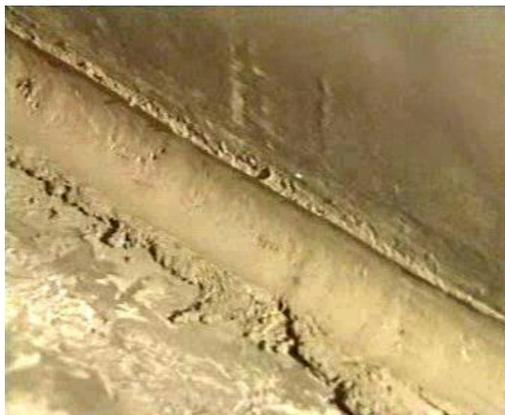
Рисунок 6.33 – Пример устройства галтелей
