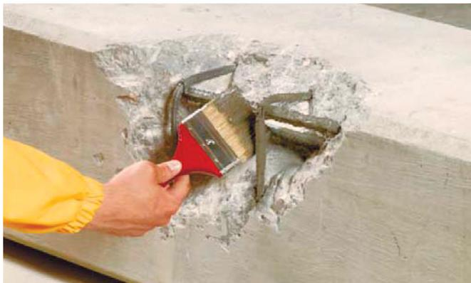
Рисунок 6.3 – Нанесение антикоррозионной защиты Ceresit CD 30 на поверхность арматуры
