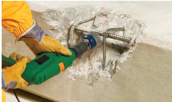
Рисунок 6.2 – Очистка от ржавчины арматурных стержней при помощи стальной щетки
