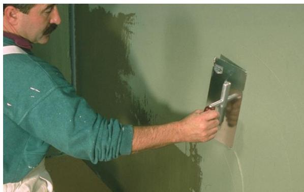
Рисунок 6.36 – Нанесение второго слоя гидроизоляционного состава Ceresit CR 65 при помощи штукатурной кельмы
