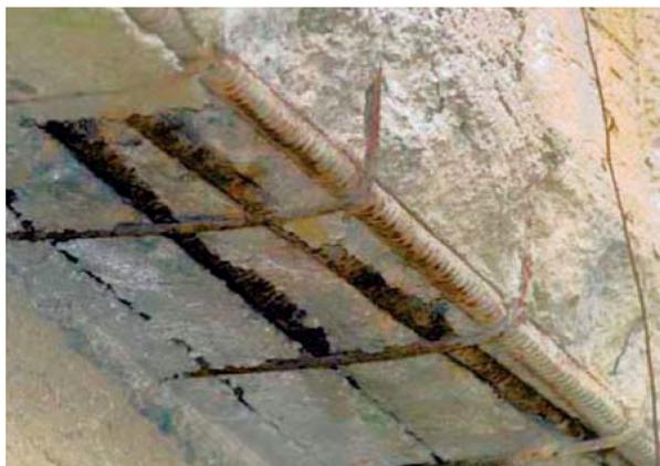
Рисунок 6.5 – Примеры разрушения железобетонных конструкций
