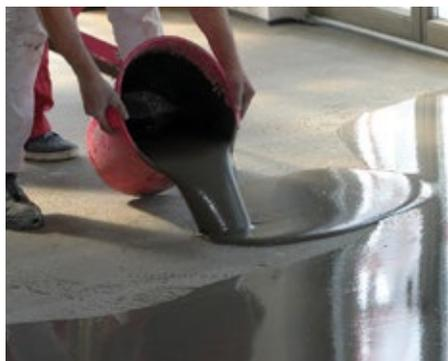
Эффект самовыравнивания достигается, начиная с определенной толщины слоя. Поэтому для получения максимально ровной поверхности смесь рекомендуется укладывать слоями толщиной не менее 3 мм.
