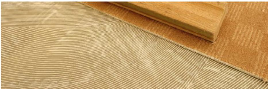
**Водно-дисперсионные клеи** часто остаются после удаления эластичных и текстильных покрытий (линолеумов, ковровых и т.д.). Как правило, они имеют резиноподобную консистенцию и цвет от светло-бежевого до коричневатого. Остатки таких клеев необходимо удалять по возможности полностью, иначе на выравнивающем слое, уложенном на ластичный клей, со временем могут появиться трещины из-за усадочных деформаций.
