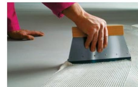
Результат зависит от правильного выбора зубчатого шпателя, равномерности нанесения клея (отсутствия наплывов и скопления клея на поверхности), соблюдения рекомендуемого времени открытой выдержки клея с учетом климатических условий и впитывающей способности основания.
