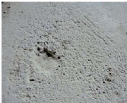
Впитывающую способность основания можно оценить следующим способом: поверхность сбрызгивают водой — если капли воды полностью впитались менее чем за 30 секунд, основание считают сильно впитывающим.
