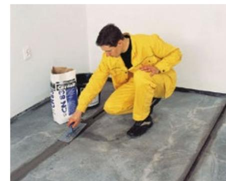
Грунтование и заделка швов после извлечения маячных реек
