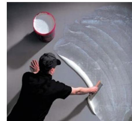
В настоящее время при укладке напольных покрытий наибольшей популярностью пользуются водно-дисперсионные клеи, характеризующиеся не только прекрасными техническими свойствами, но и высокой безопасностью для окружающей среды и здоровья людей.
