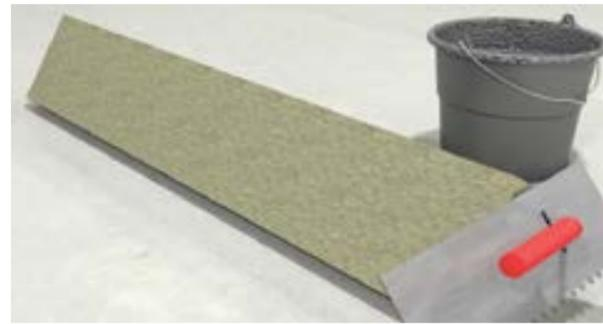
2. Нанесение клеевой смеси на тыльную поверхность ламели PAROC CGL 20 с помощью зубчатого шпателя.
