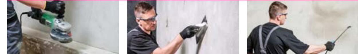
Очистку основания рекомендуется производить пескоструйной обработкой или водой под высоким давлением. Перед нанесением гидроизоляционной смеси основание необходимо увлажнить до насыщения, не допуская образования потеков и скоплений воды.
