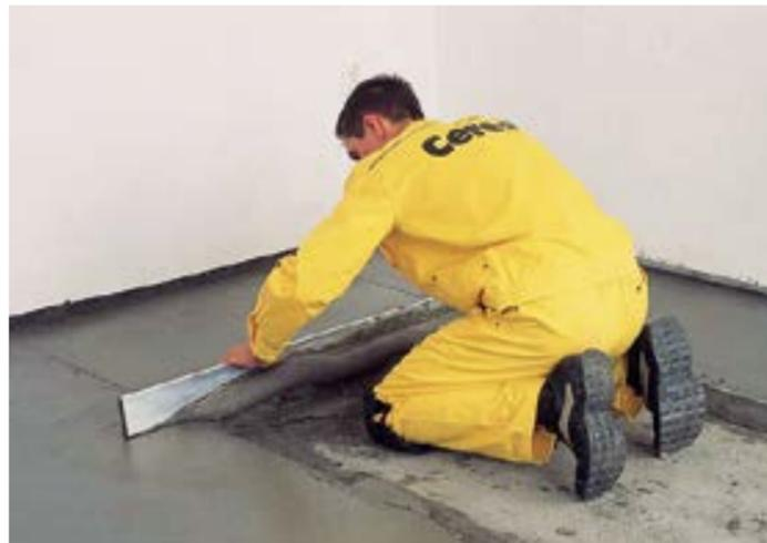
**Высокопрочная выравнивающая смесь для пола Ceresit CN 88 (толщина слоя от 5 до 50 мм) для значительных нагрузок:**
