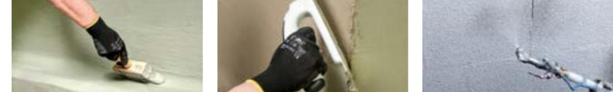
**Материал наносят** 2 или 3 слоями равномерной толщины. Первый слой рекомендуется наносить кистью.
