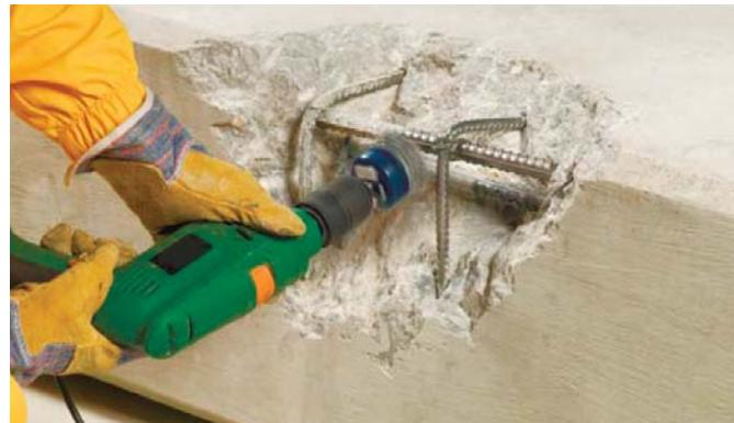
На подготовленную таким образом поверхность арматурных стержней кистью нанести антикоррозионное покрытие из смеси Ceresit CD 30. При нанесении антикоррозионной смеси металл может быть влажным. Антикоррозионную смесь следует наносить не позднее 3-х часов после очистки арматурных стержней.
