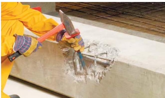
Дефектные участки необходимо оконтурить под прямым углом при помощи угловой шлифовальной машины с алмазными дисками, отбойного молотка или зубила на глубину не менее 10 мм.
