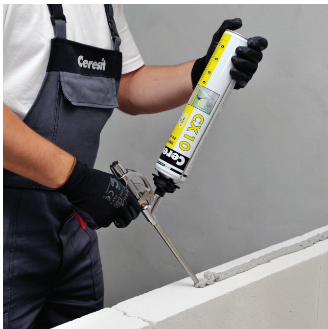
Aplikacja piany podczas łączenia bloczków z betonu komórkowego
