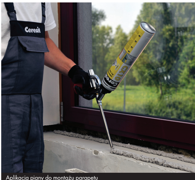
Aplikacja piany do montażu parapetu
