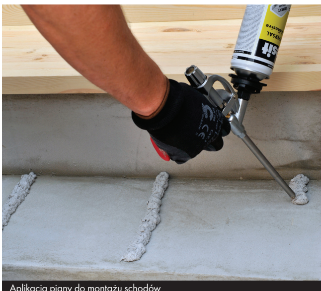
Aplikacja piany do montażu schodów
