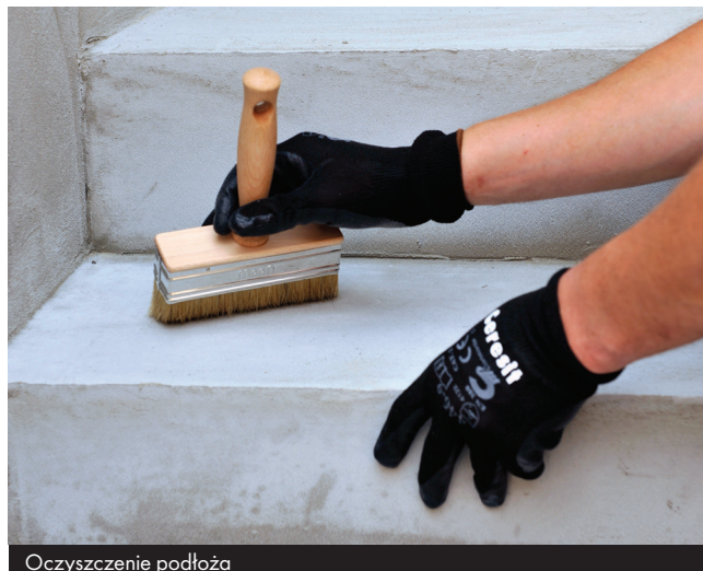
Oczyszczenie podłoża
