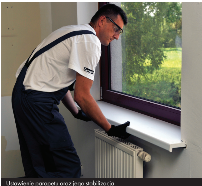
Ustawienie parapetu oraz jego stabilizacja
