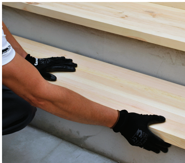
Ustawienie stopnicy oraz jej stabilizacja
