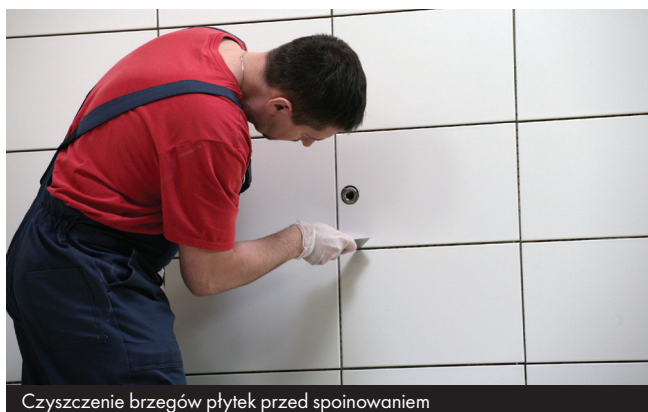
Czyszczenie brzegów płytek przed spoinowaniem
