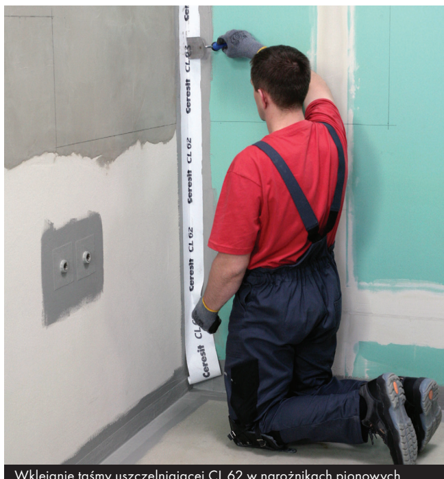
Wklejanie taśmy uszczelniającej CL 62 w narożnikach pionowych.
