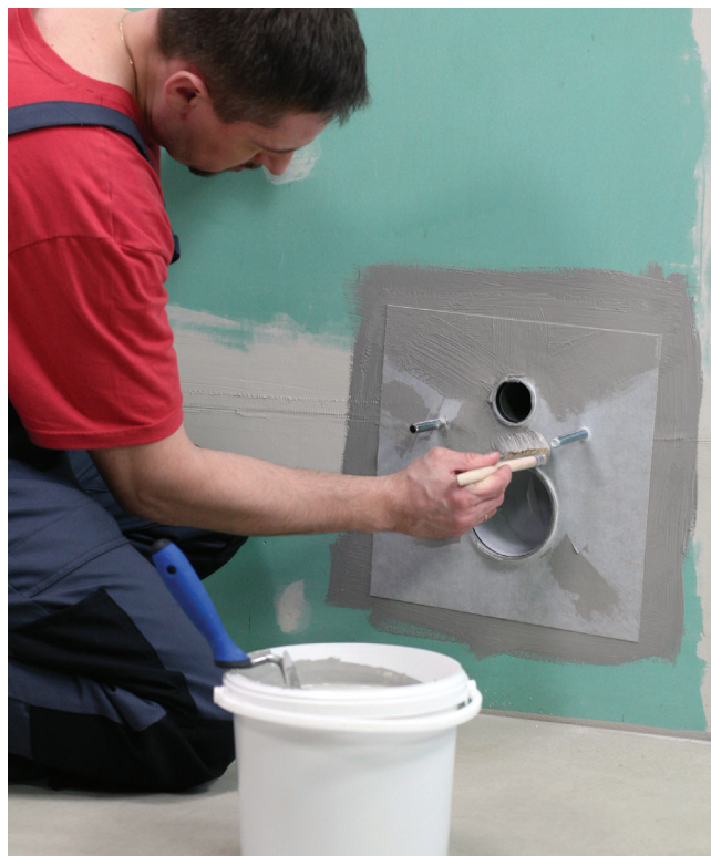
Wklejanie taśmy uszczelniającej lub fizeliny technicznej o gramaturze max. 60 g/m 2 na przejściach rur instalacyjnych
