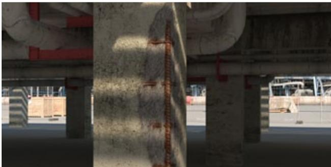
**Concreto erosionado y corrosión del acero de refuerzo.** Los factores externos y ambientes severos, degradan los concretos, afectando incluso el acero de refuerzo en las edificaciones.
