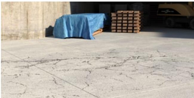
**Daños por movimientos.** El tránsito pesado o los movimientos sísmicos dañan severamente los concretos, ya sean en losas, pisos, muros, trabes, etc.
