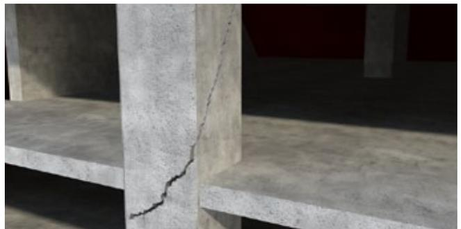
**Concreto agrietado.** Así mismo los movimientos generan grietas en el concreto poniendo en riesgo la capacidad estructural del mismo.
