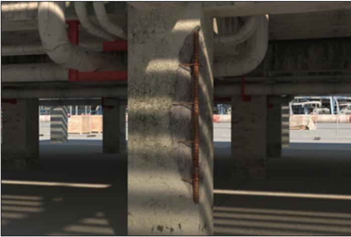
**PASOS:** **1** Retire el concreto dañado hasta llegar a concreto sano. Si el acero de refuerzo presenta corrosión es necesario descubrir toda la varilla, tanto la parte ciega como la parte frontal y aplicar **Fester CM-100** a 2 manos esperando 30 minutos entre cada aplicación y esperando a que seque levemente previo a la aplicación del mortero reparador.
