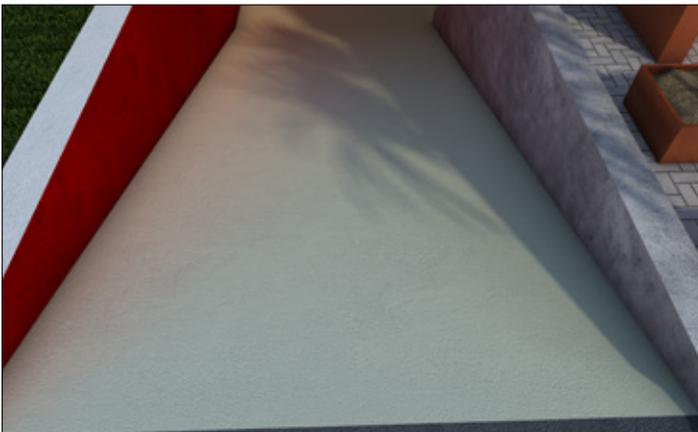
**3** Una vez aplicado el primario, coloque la primera capa impermeable.
