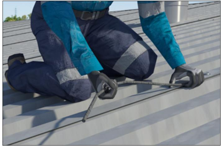
**1** Antes de trabajar en la superficie, asegúrese de que ésta no presente salientes, partes sueltas, que esté limpia, seca y libre polvo; retire además falsas adherencias del material de construcción, pintura o recubrimientos envejecidos, salitre, etc.
