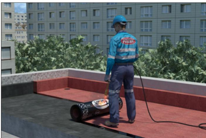
**3** Caliente por medio de soplete de gas la cara interior de una sección del **FesterMIP Garden** hasta fundir y asiente de inmediato sobre la superficie. Para la colocación de los rollos siguientes, deje traslapes de 10 cm a los lados y 10 cm sobre los extremos de cada rollo.
