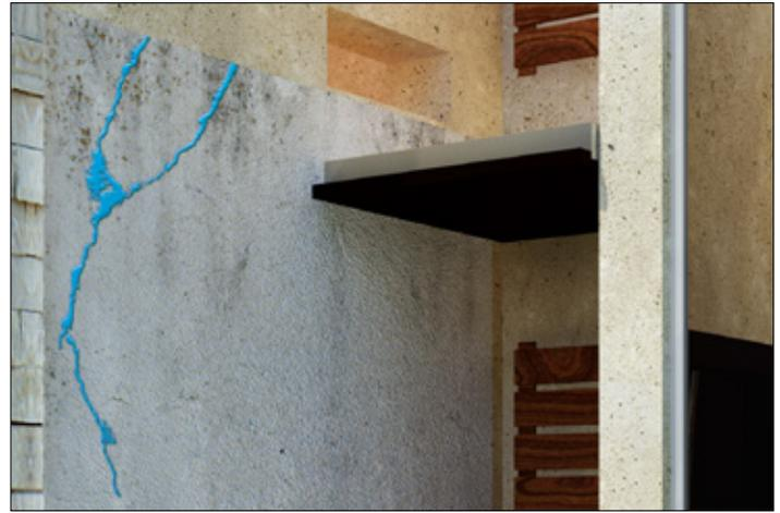
**1** Preparación de la superficie: Los laterales de la junta deben estar bien perfilados, sanos, sin desportilladuras, sin partes sueltas, libre de partículas y polvo, completamente secos, libres de membranas de curado y pinturas. La limpieza de la superficie de concreto, morteros y ladrillos debe llevarse a cabo con cepillos de alambre, lija y cepillo de cerdas duras; posteriormente eliminar el polvo con escoba y con aire a presión.
