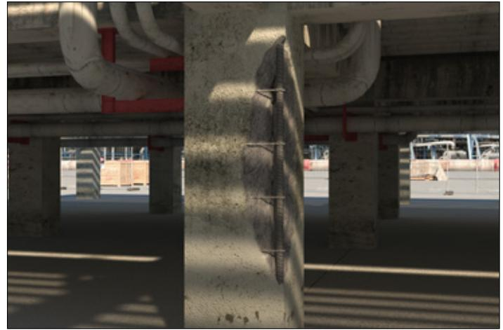
**2** En áreas pequeñas y medianas aplique **Fester CM-201**, gracias a su consistencia pastosa permite aplicar capas de hasta 10 cm. Si el área a reparar es grande aplique **Fester CM-202**, por su fluidez brinda la facilidad de colocar una cimbra y vaciar el mortero reparando grandes áreas muy rápido.
