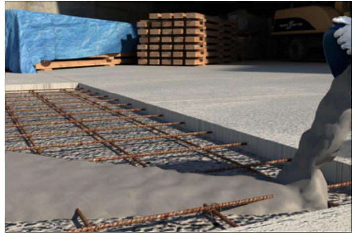
**2** Prepare el mortero **Fester CM-202** agregando 4 litros de agua por saco de 25 kg incorporando hasta lograr una mezcla homogénea y vacíe dentro de la caja hasta llegar al nivel del piso, su fluidez le permite nivelarse por sí sólo.
