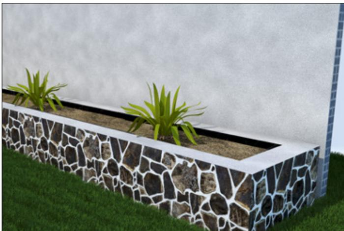
**1** Antes de trabajar sobre la superficie, asegúrese de que ésta no presenta salientes, partes sueltas, que esté limpia, seca y libre polvo; retire además falsas adherencias del material de construcción, pintura o recubrimientos envejecidos, salitre, etc.
