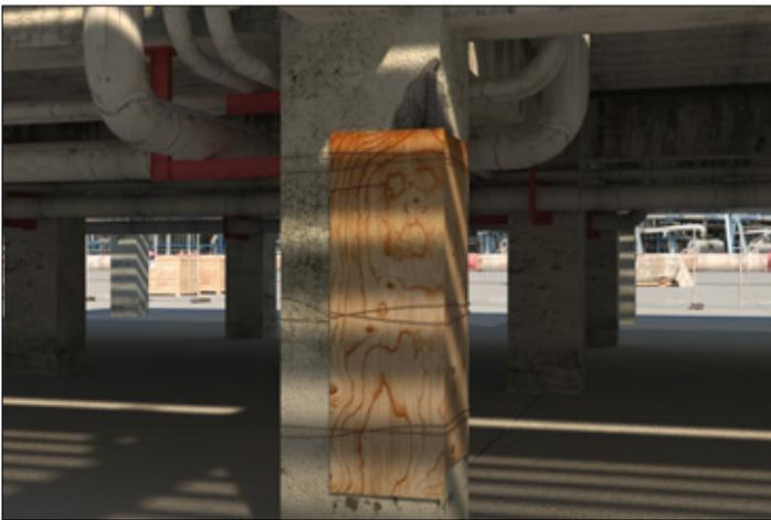
**3** Se recomienda aplicar desmoldante **Fester Cimbrafest** a la cimbra y colocarla herméticamente para evitar fuga de material. Prepare ambos morteros agregando 4L de agua por saco y preparando sólo el material que se aplicará en 20 minutos.
