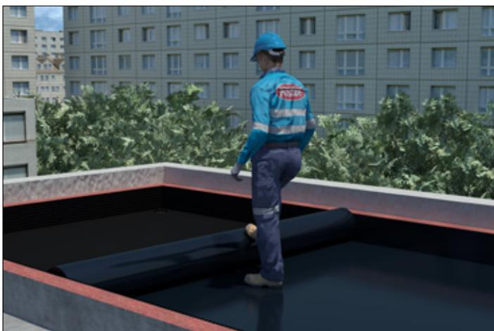
**5** Coloque el rollo de **Fester Polietileno** cubriendo completamente la superficie al ras de los muros o pretilas. Considere un traslape mínimo de 25 cm.
