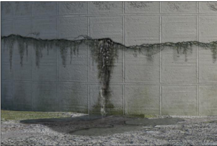
**PASOS:** **1** Realice la limpieza del elemento retirando membranas de curado, recubrimientos, aplanados o pinturas, posteriormente abra un poro en el concreto y verifique que el elemento de concreto esté estructuralmente sano y que tenga una edad mínima de 28 días de colado.
