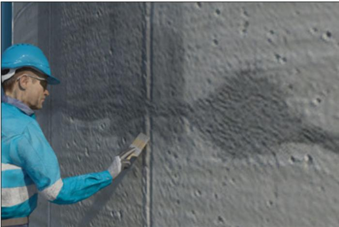
**3** Impermeabilice la totalidad del elemento con **FESTER CR-NANOTECH® 99+**, prepare la lechada mezclando 5 partes iguales de **FESTER CR-NANOTECH® 99+** con 2 partes de agua limpia.
