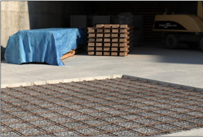
**PASOS:** **1** Remueva el concreto dañado y abra una caja en toda la sección del piso dañado.
