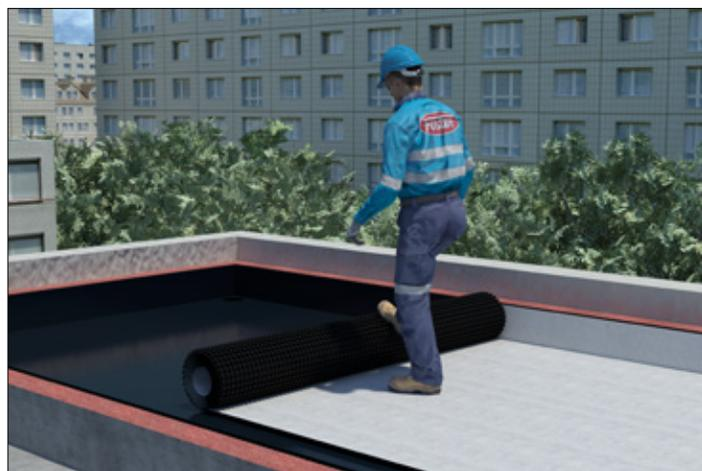
**6** Coloque el rollo de **Fester Filtro** cubriendo completamente la superficie al ras de los muros o pretilas dejando la membrana geotextil en la parte superior que recibirá el sustrato, considere un traslape mínimo de 10 cm.
