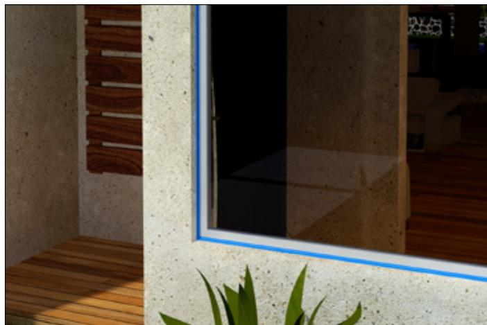
**2** Utilizando pistola de calafateo, aplique el sellador rellenando la junta y perfilando con una espátula de punta redonda antes de que transcurran 15 minutos, para dar el acabado deseado. Quite la cinta y limpie el exceso de producto con un trapo seco, mientras el sellador esté fresco.
