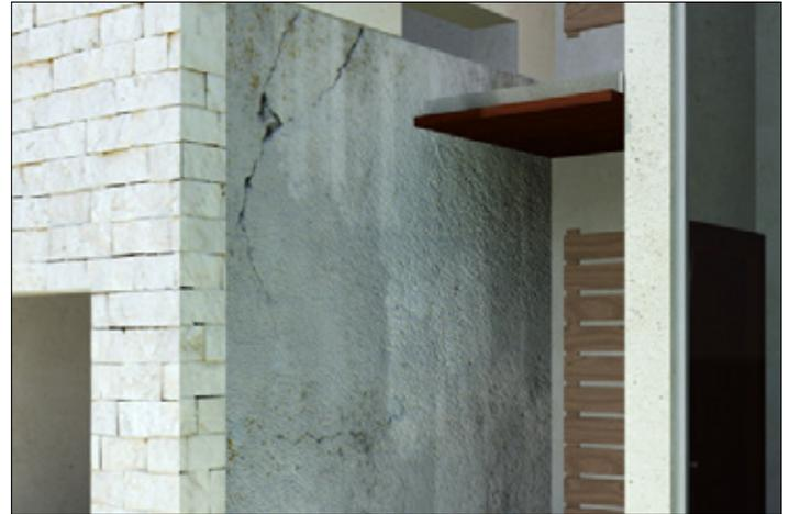
**1** Antes de trabajar sobre la superficie, asegúrese de que ésta no presenta salientes y partes sueltas, que esté limpia, seca y libre polvo; retire además falsas adherencias del material de construcción, recubrimientos envejecidos, pintura, salitre y en general cualquier sustancia que impida la adherencia a la superficie.
