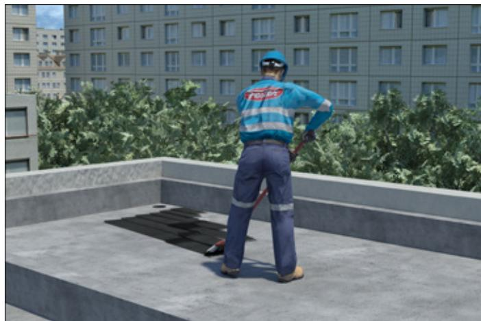
**2** Utilizando rodillo, brocha o cepillo aplique una capa uniforme de **Fester Hidroprimer** sobre la superficie sin diluir el producto. Deje secar un mínimo de 4 horas antes de instalar el **FesterMIP Garden**.
