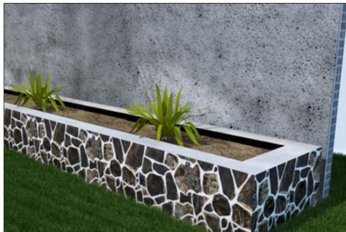
**2** Aplique **Fester Hidroprimer**, usando guantes resistentes a solventes para protección personal sobre la superficie a tratar, utilizando cepillo, brocha o pistola de alta presión. Deje secar por espacio de 4 hrs aproximadamente y permita que seque completamente antes de aplicar las capas impermeables.
