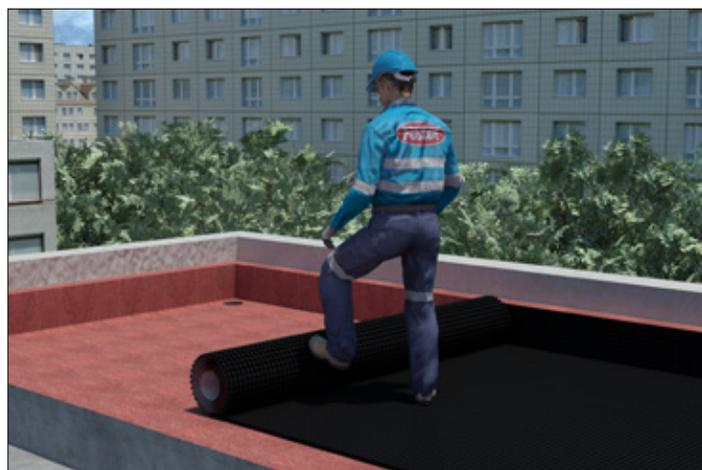
**4** Coloque el rollo de **Fester Drenante** cubriendo completamente la superficie al ras de los muros o pretilas. Ensamble las uniones entre rollos considerando un traslape mínimo de 10 cm.
