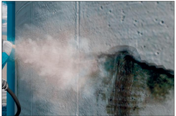
**2** Mediante agua a presión y con un cepillo, elimine el polvo y al mismo tiempo sature la superficie con agua limpia.
