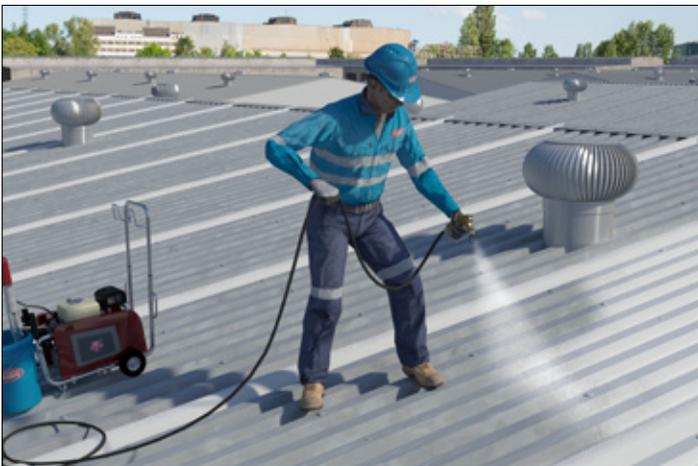
**3** Aplique **Fester Acriton Híbrido** con el sistema de aspersión tipo Airless, respetando los rendimientos indicados, deje secar de 2 a 3 horas entre capas.
