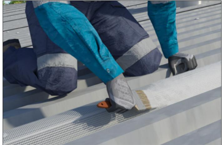
**3** Realice el tratamiento de tornillería y traslapes; utilice una pistola de calafateo y aplique **Fester Superseal P** firmemente asegurando que tenga contacto total con las paredes de la junta y evitando la formación de burbujas de aire.
