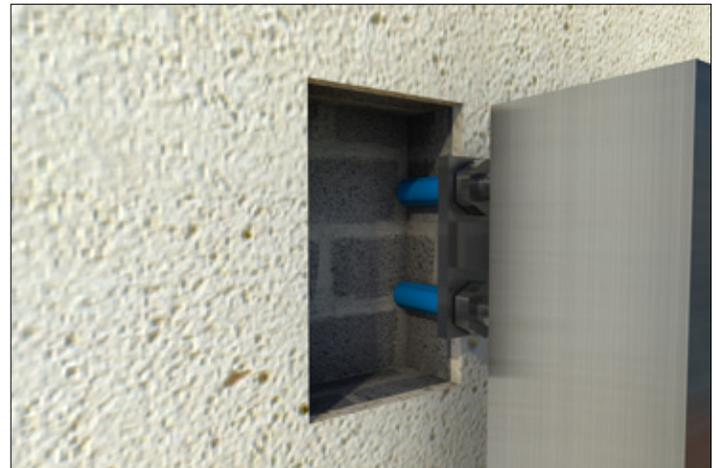
**3** Inserte el perno o varilla girando y retire el excedente de producto.
