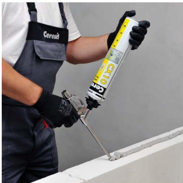
Klijų paskleidimas jungiant akytojo betono blokelių
