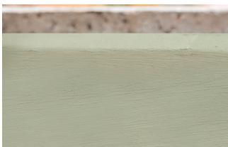
Капиллярная абсорбция воды дает возможность растворенным в воде агрессивным веществам, таким как хлориды и другие соли, проникать в структуру бетона, вызывая коррозию стального армирования и другие повреждения структуры. На влажной основе из бетона также скапливается грязь, образуется грибок и плесень, портит ее вид и вызывает разрушение.
