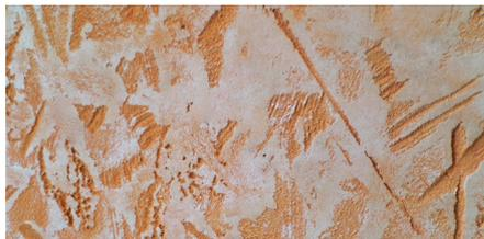
Полиминеральная штукатурка Ceresit СТ 36, инструмент нанесения: стальная терка, инструмент фактурирования: Венецианский шпатель, шпатель.
