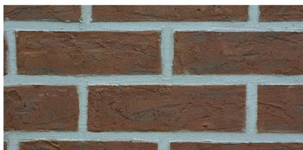
Полиминеральная штукатурка Ceresit СТ 36, инструмент нанесения: стальная терка, инструмент фактурирования: Венецианский шпатель, шпатель, губка.
