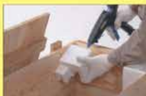
緩衝材の接着
