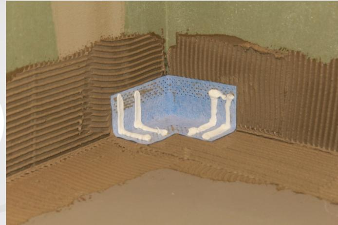
▶ CL86 (Innenecke) in CL50 einbetten und im Überlappungsbereich FT101 raupenförmig auftragen
