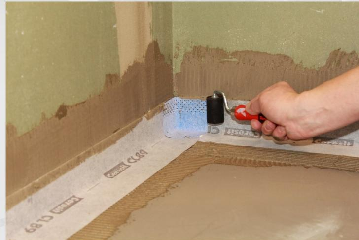
▶ Andruckrolle für optimalen Pressdruck bei FT101 (zur Vermeidung von Erhöhungen im Überlappungsbereich)
