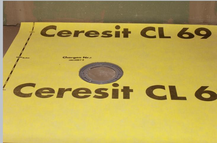
▶ CL69 (Bahnenware) und Systemkomponenten (Dichtbänder) zuschneiden
