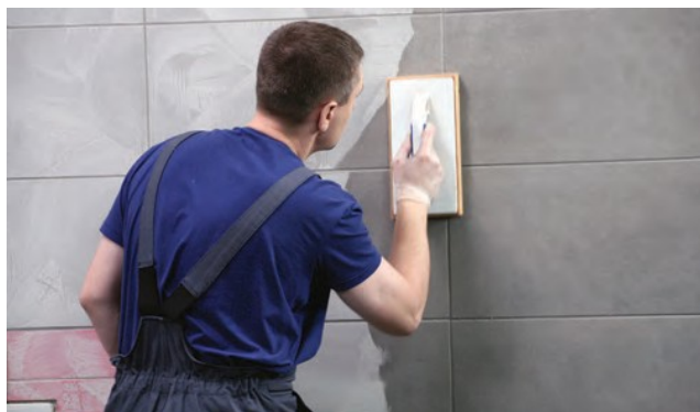
Profileerimise aeg on 5–30 minutit.
