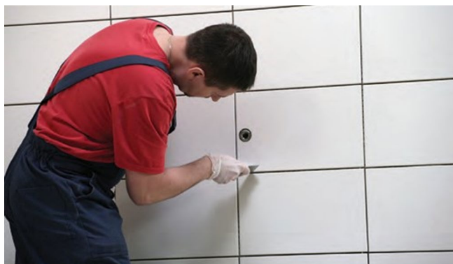
Plaadiservade puhastamine enne vuukimist.
