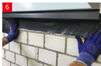
6 Andrücken der Folie am Baukörper
