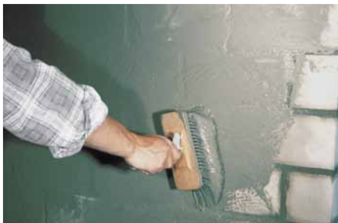
Aplicarea CR 90 Crystaliser cu bidineaua
