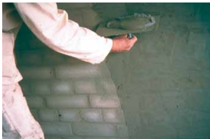
Aplicarea CR 90 Crystaliser cu gletiera
