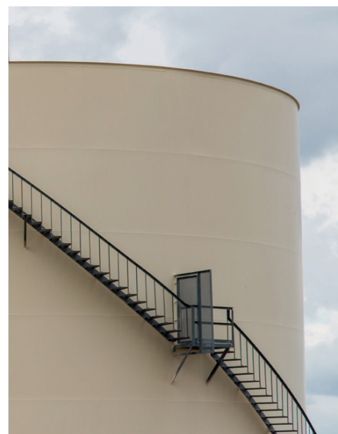
Rezervoari za vodu
