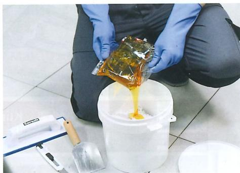
Den Inhalt der Komponente B (Härtungsmittel in einem Kunststoffbeutel) der Komponente A (Harz) hinzufügen.
