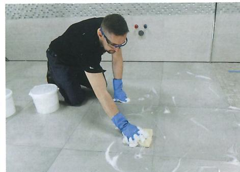
Reinigung und Endbearbeitung: Die geflieste Fläche kann unmittelbar nach dem Auftragen der Fugenmasse gereinigt werden. Dazu einen normalen feuchten Schwamm verwenden
