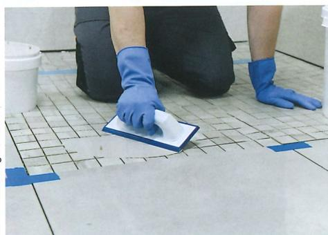
Anwendung als Fugenmasse: Die Mischung mit einem passenden Fugenbrett in die sauberen, trockenen Fugen einstreichen. Dabei darauf achten, dass beim Füllen der Fugen keine Hohlräume entstehen
