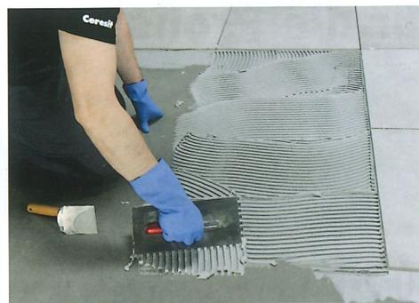
Anwendung als Fliesenkleber: Ceresit ULTRAEOXY direkt dem Mischbehälter entnehmen und mit dem Spachtel genauso wie einen zementbasierten Dünnbettmörtel auftragen
