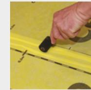
Die Überlappungen von mindestens 5 cm an CERESIT Dichtecken, Dichtbändern und Manschetten sind mit CERESIT FT 101 wasserdicht zu verkleben.
