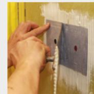
Rohrdurchführungen und Anschlüsse sind mit CERESIT Dichtmanschetten (CL 83) bzw. CL 69 Abdichtungsbahn fachgerecht auszuführen.
