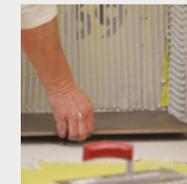
Im Wandbereich können Fliesen und Platten ohne Wartezeit mit CERESIT Fliesenkleber direkt auf der CERESIT Abdichtungs- und Entkoppelungsbahn verlegt werden. Im Bodenbereich sollten erst nach Aushärten des Klebers Fliesen verklebt werden.
