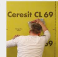
Um eine ebene, gleichmäßige Oberfläche zu erzielen, wird die Bahn mit einer Hartgummiwalze oder mit der flachen Seite der Kelle angedrückt.
