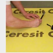
Nun folgt die eigentliche Flächenabdichtung mit der CERESIT CL 69 Abdichtungs- und Entkoppelungsbahn. Die CL 69 Abdichtungs- und Entkoppelungsbahn auslegen und mit Cutter oder Schere an die örtlichen Gegebenheiten anpassen.
