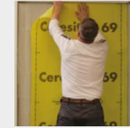
CERESIT Klebemörtel mit einer 4 mm Kammkelle auftragen und CERESIT CL 69 innerhalb der klebeoffenen Zeit mit mindestens 5 cm Überlappung (siehe Kennzeichnung der Bahn) überdecken und andrücken.
