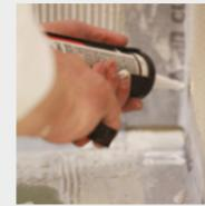
Die Überlappungen von mind. 5cm an CERESIT Dichtbändern, Dichtecken (CL 87, CL 86) und Manschetten (CL 83) sind mit CERESIT FT 101 zu verkleben.
