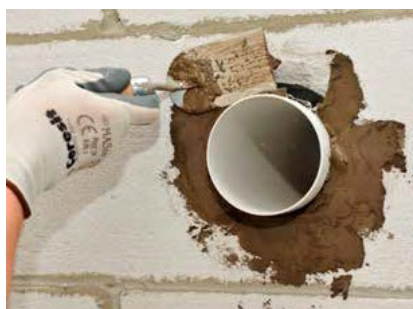
Nanesite montažno malto Ceresit CX5 Express (predhodno navlažena podlaga)
