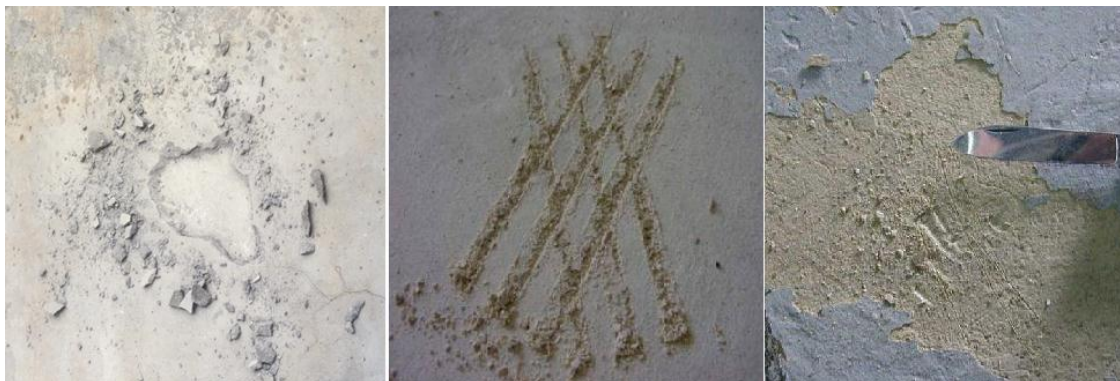
Рисунок 5. Непрочные основания
