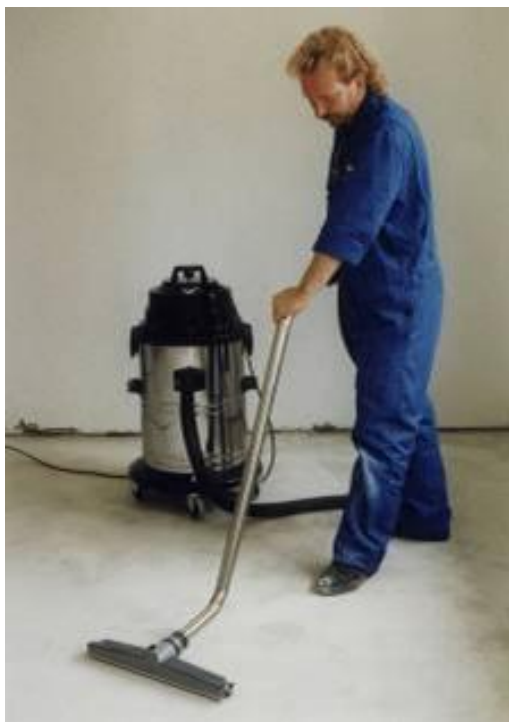
Рисунок 9. Обеспыливание основания
