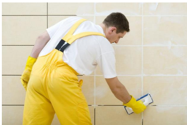
Рисунок 24. Заполнение межплиточных швов затиркой
