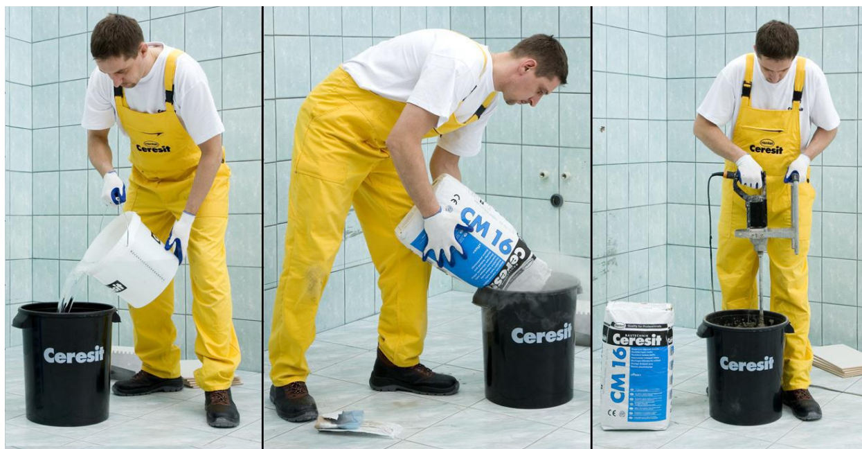
Рисунок 17. Приготовление клеевой смеси
