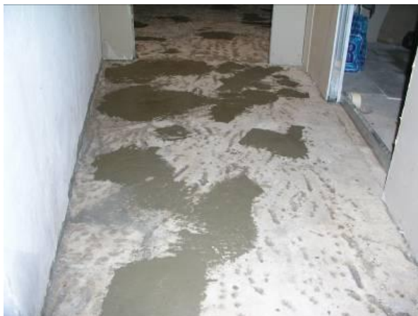
Рисунок 8. Ремонт пола быстротвердеющим составом Ceresit CX 5
