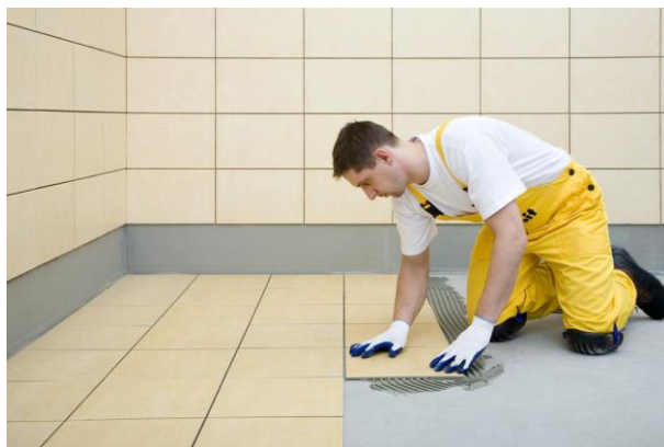
Рисунок 23. Укладка плиток на пол (горизонтальные поверхности)
