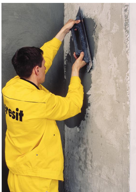
Рисунок 7. Выравнивание стен штукатурными смесями
