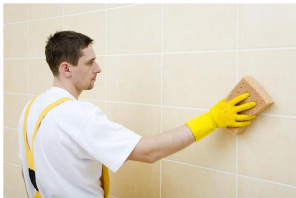
Рисунок 25. Заглаживание затирки губкой
