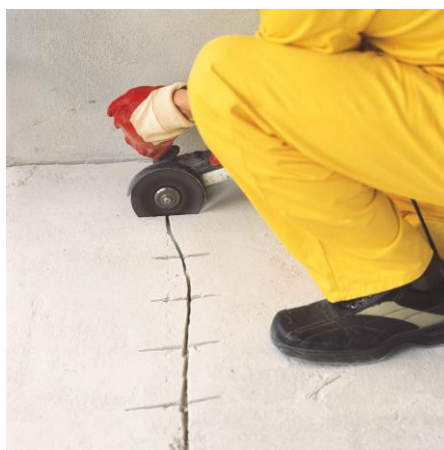
Рисунок 6. Расшивка трещин в основании пола
