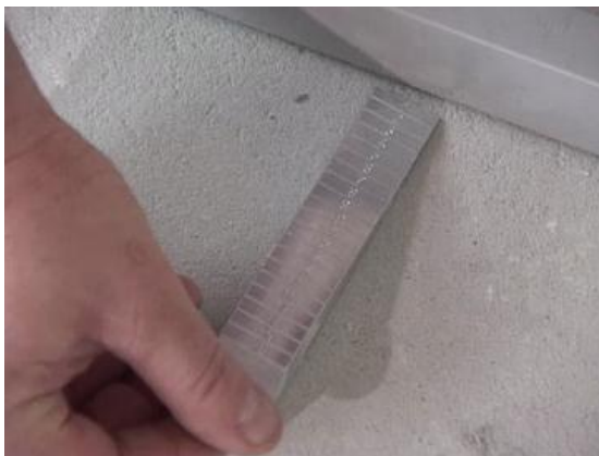
Рисунок 3. Проверка ровности основания контрольной рейкой и клином-измерителем
