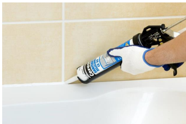
Рисунок 27. Заполнение горизонтального шва примыкания силиконовой затиркой
