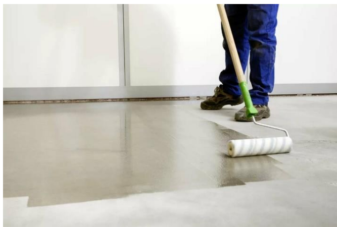
Рисунок 11. Обработка впитывающего основания пола грунтовкой Ceresit CT 777
