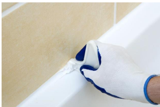
Рисунок 29. Заравнивание силиконовой затирки в шве
