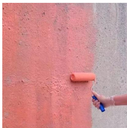
Рисунок 12. Обработка бетона адгезионной грунтовкой Ceresit CT 19 Бетонконтакт
