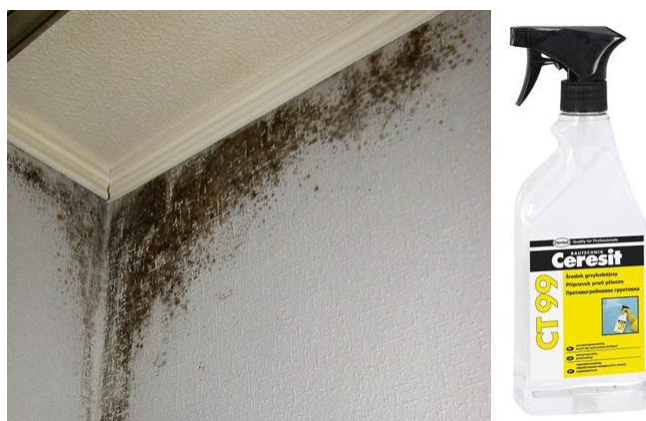
Рисунок 4. Обработка биологических загрязнений фунгицидным составом Ceresit СТ 99
