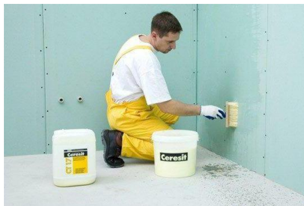
Рисунок 10. Обработка впитывающего основания грунтовкой Ceresit CT 17
