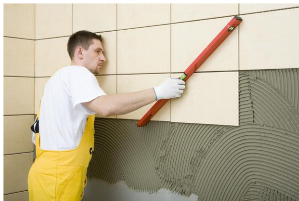
Рисунок 21. Проверка облицовки при помощи уровня
