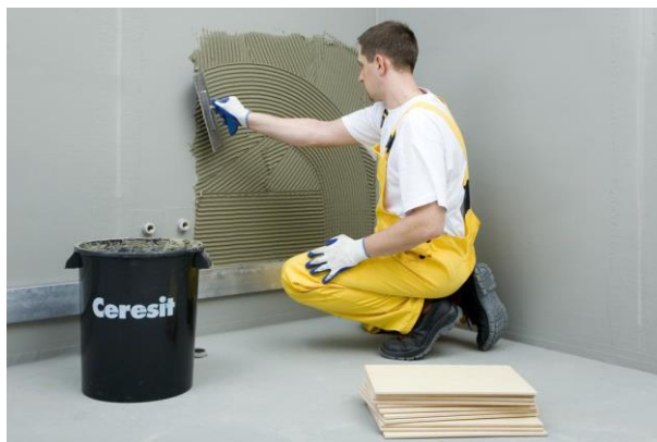
Рисунок 19. Нанесение клеевой смеси на основание
