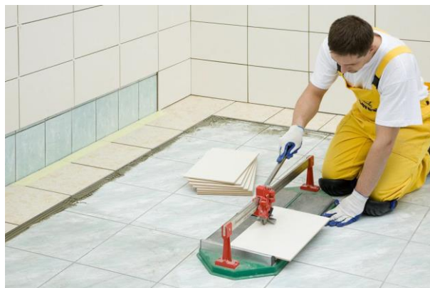
Рисунок 22. Резка плитки при помощи рычажного плиткореза
