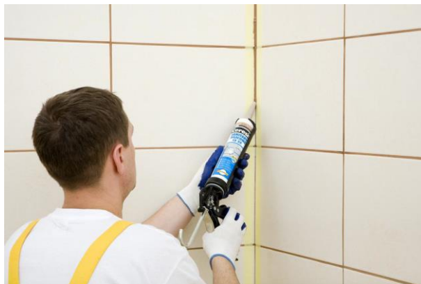
Рисунок 28. Заполнение вертикального углового шва силиконовой затиркой
