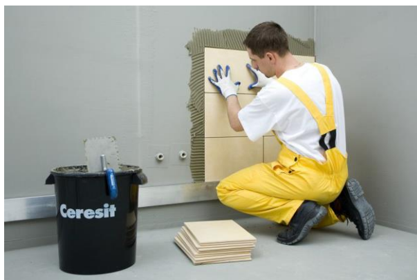
Рисунок 20. Приклеивание плитки на стену
