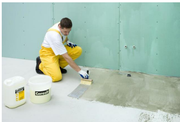
Рисунок 10. Обработка впитывающего основания грунтовкой Ceresit CT 17
