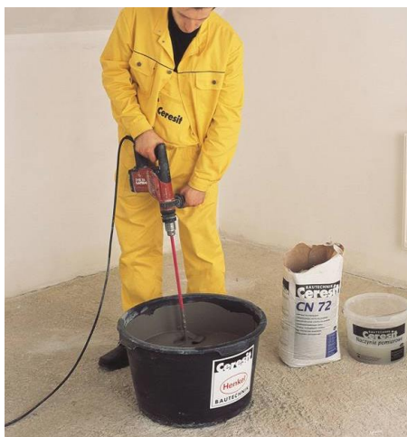
Рисунок 9. Приготовление составов ручным способом
