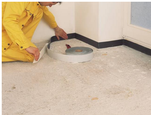
Рисунок 12. Устройство изоляционного шва из демпферной ленты
