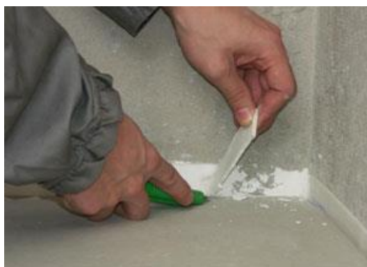
Рисунок 17. Обрезка выступающей демпферной ленты
