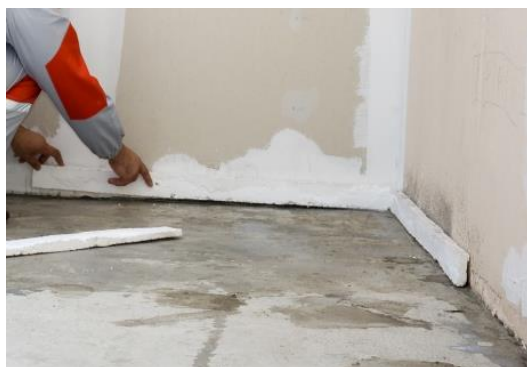
Рисунок 13. Установка изоляционного шва из полосок пенополистирола
