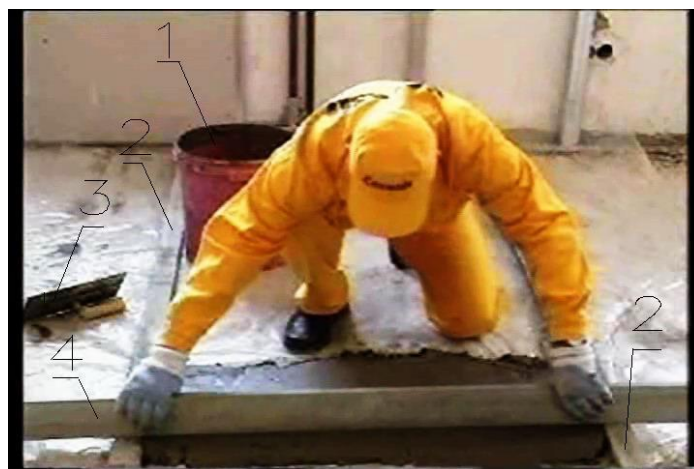
1 – емкость с раствором; 2 – маячные рейки; 3 – терка; 4 – рейка-правило б) вытягивание смеси по маячным рейкам рейкой-правилом
