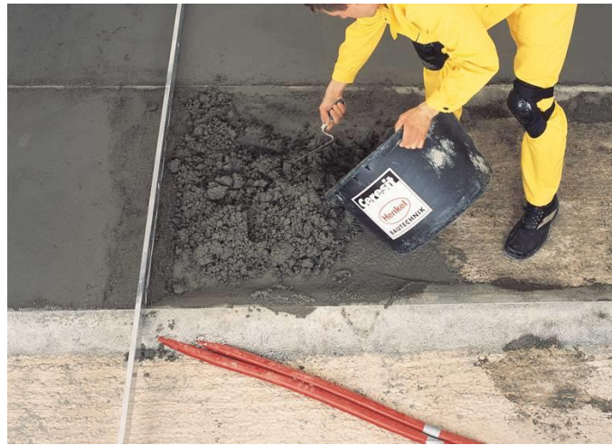
а) распределение смеси между маячными рейками с помощью кельмы
