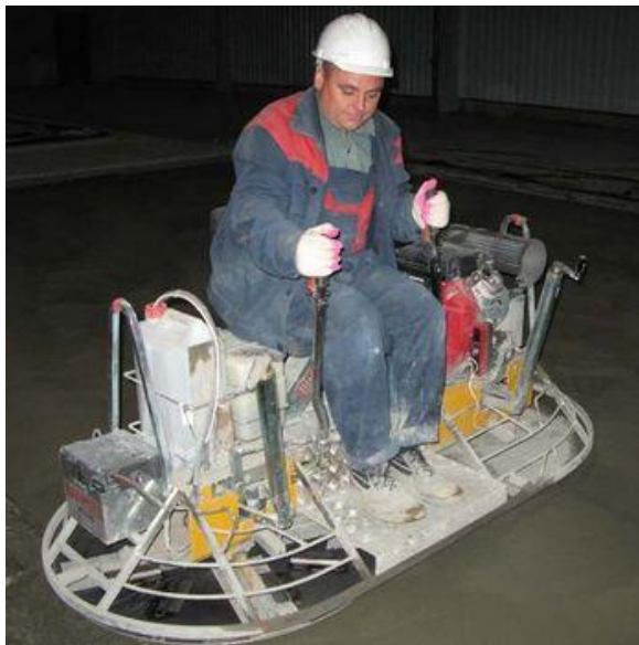
Рисунок 9. Окончательное заглаживание топпинга бетоноотделочной машиной
