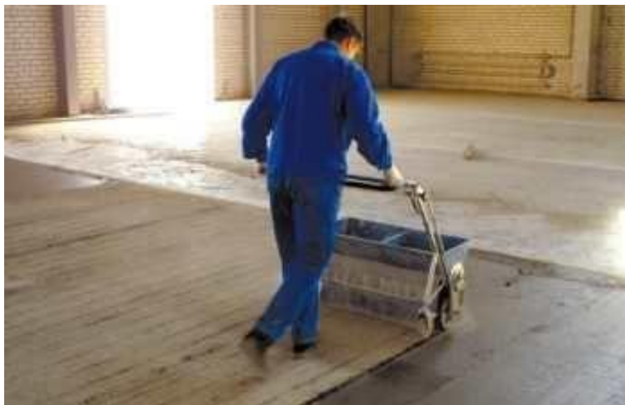
Рисунок 6. Нанесение первого слоя топпинга
