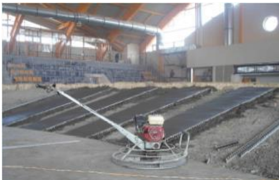
Рисунок 1. Разбивка основание на карты при бетонировании
