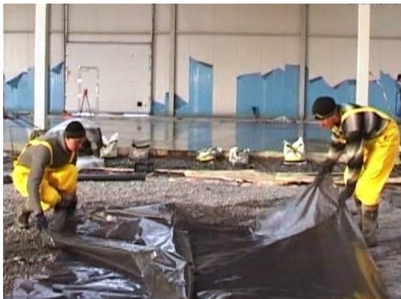
Рисунок 2. Устройство гидроизоляции
