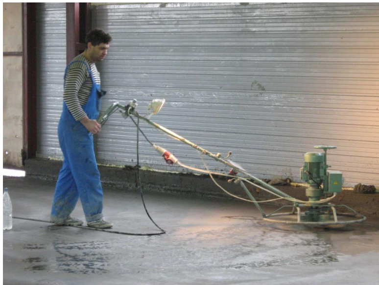
Рисунок 7. Затирка первого слоя топпинга ручной бетоноотделочной машиной
