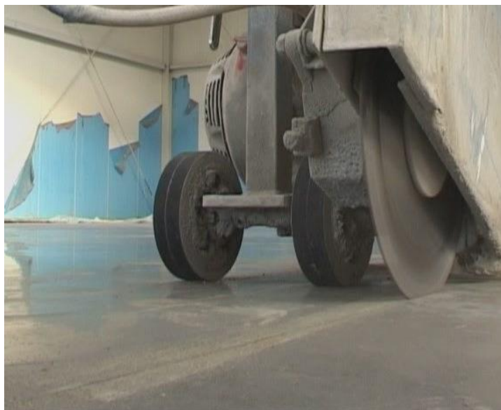
Рисунок 10. Нарезка усадочных швов
