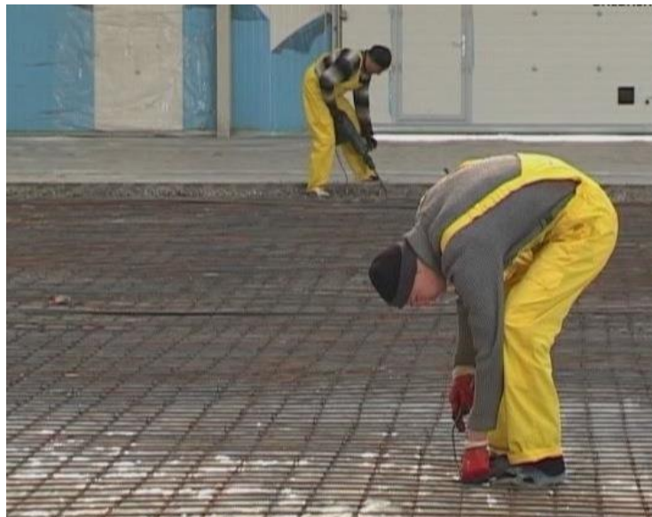
Рисунок 3. Армирование карт
