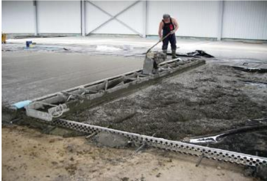
Рисунок 5. Виброуплотнение бетонной смеси
