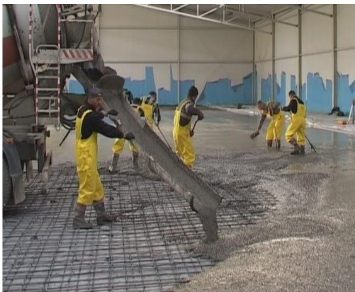
Рисунок 4. Укладка бетонной смеси в карту
