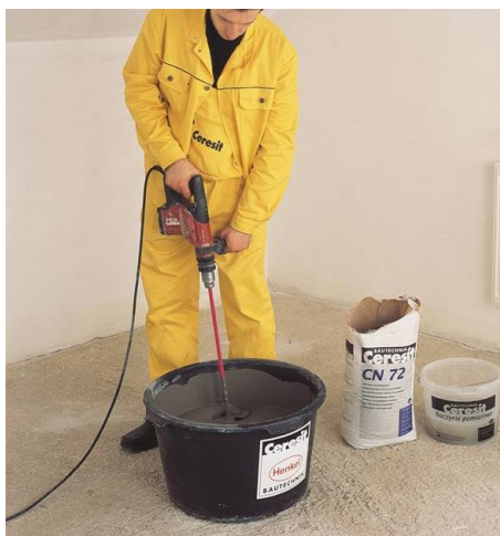
Рисунок 6. Приготовление составов ручным способом
