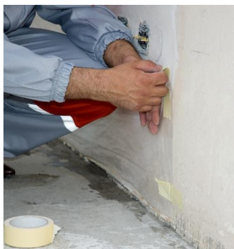
Рисунок 4. Защита стен полиэтиленовой пленкой
