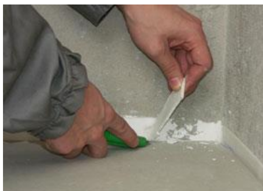
Рисунок 18. Обрезка выступающей демпферной ленты
