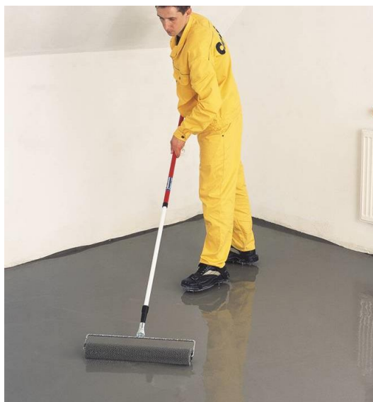
Рисунок 17. Деаэрация уложенной смеси игольчатым валиком
