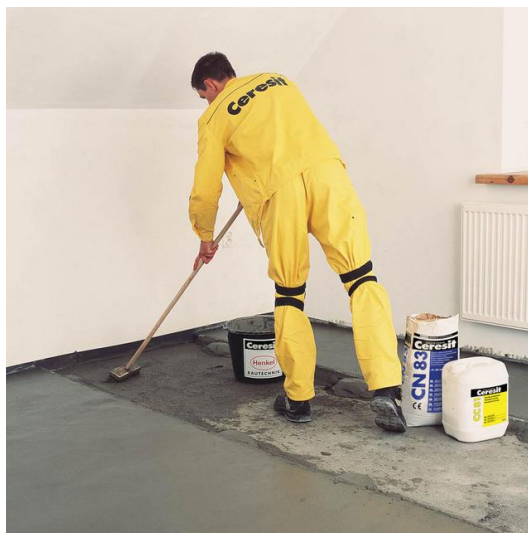
Рисунок 11. Изготовление адгезионного слоя
