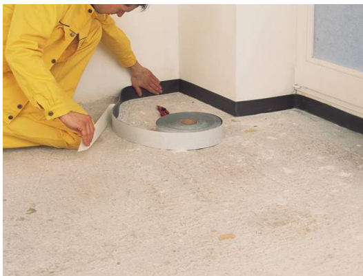
Рисунок 2. Устройство изоляционного шва из демпферной ленты
