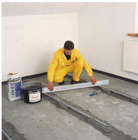
Рисунок 5. Установка маячных реек на маяки из смеси Ceresit CN 83
