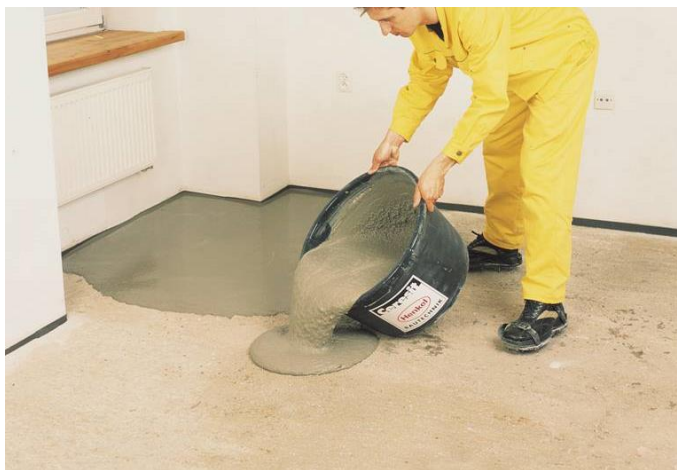
Рисунок 15. Укладка самовыравнивающейся смеси
