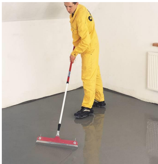
Рисунок 16. Распределение смеси по поверхности основания зубчатой раклей
