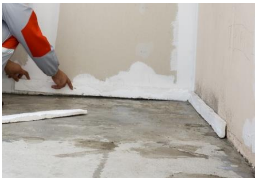
Рисунок 3. Установка изоляционного шва из полосок пенополистирола
