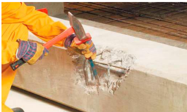
Рис. 3. Удаление слоев бетона, утративших сцепление с основанием.
