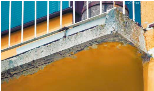
а) Балконная плита
