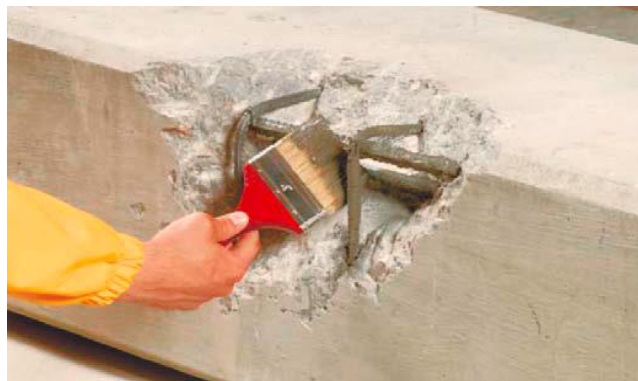
Рис. 5. Нанесение антикоррозионной защиты Ceresit CD 30 на поверхность арматуры.
