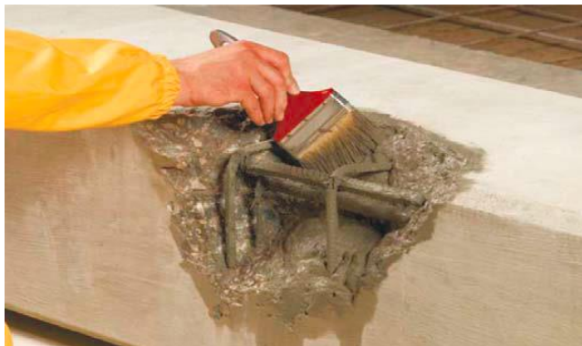
Рис. 6. Устройство контактного слоя Ceresit CD 30 .
