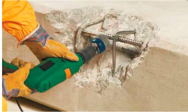
Рис. 4. Зачистка арматуры от ржавчины при помощи металлической щетки.
