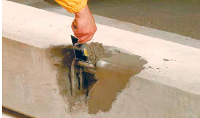
Рис. 7. Нанесение выравнивающего ремонтного состава.
