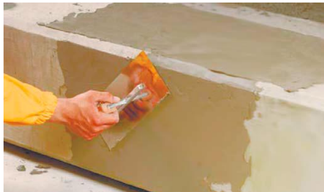
Рис. 8. Нанесение полимерцементной шпатлевки Ceresit CD 24 .
