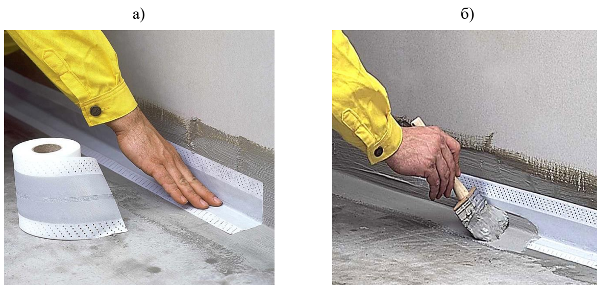
а – укладка ленты; б – нанесение второго слоя гидроизоляционного состава
