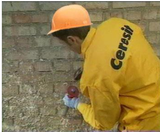
Рисунок 1. Очистка поверхности зубилом и молотком
