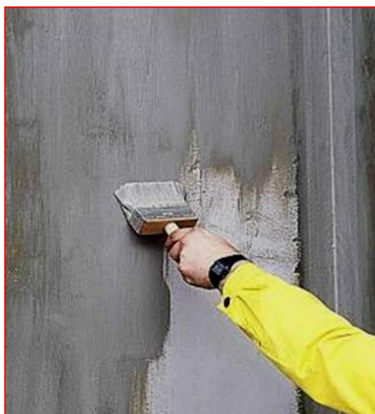
Рисунок 14. Нанесение первого слоя гидроизоляционного состава
