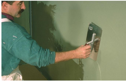
Рисунок 15. Нанесение второго слоя гидроизоляционного состава Ceresit CR 65
