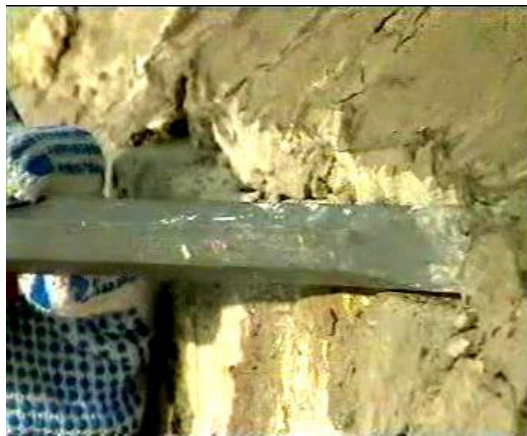
Рисунок 3. Удаление штукатурного слоя
