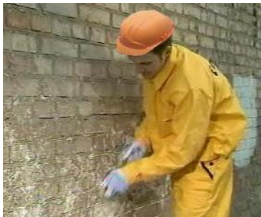
Рисунок 2. Удаление отделочного слоя щеткой
