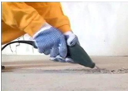
а – перфоратором; б – угловой шлифовальной машиной с отрезным кругом
