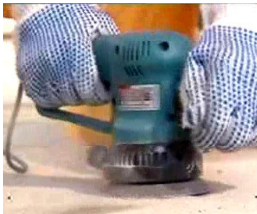
Рисунок 6. Удаление пятен от битума, красок шлифовальной машиной
