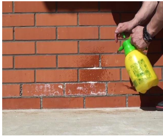
Рисунок 4. Удаление солевых отложений преобразователем солей
