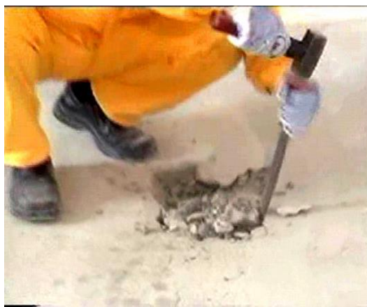
Рисунок 7. Удаление непрочного слоя основания
