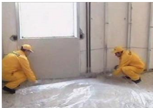
Рисунок 16. Укрытие гидроизоляционного покрытия полиэтиленовой пленкой
