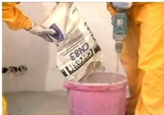
Рисунок 9. Приготовление состава Ceresit CN 83 с адгезионной добавкой Ceresit CC 81
