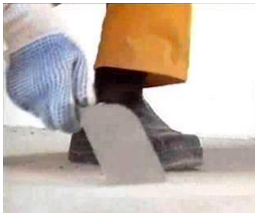
Рисунок 5. Удаление цементного молочка шпателем
