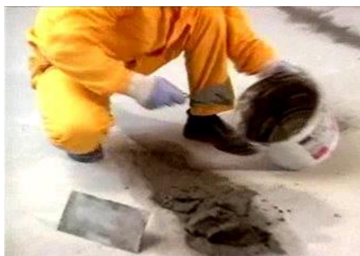
Рисунок 10. Заделка выбоин и впадин составом Ceresit CN 83
