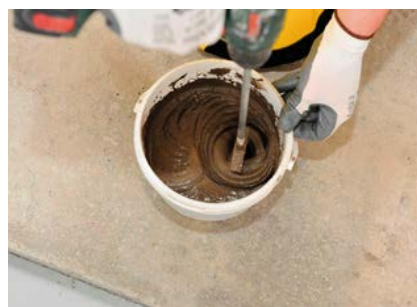
3. Mešajte dok se ne postigne homogena masa bez grudvica, oko 30s
