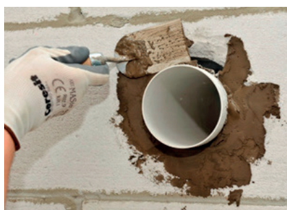
5. Sastavite pomoću cementa Ceresit CX5 Express (podlogu prethodno navlažiti)
