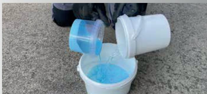
CN 94 je **koncentrat i na jednostavan način se može razblažiti sa vodom**. Preporučeni odnos je **1:3**, ali to zavisi od površine na koju se nanosi (više informacija pronađite u Tehničkom listu). Proizvod se može koristiti na temperaturama vazduha i podloga od +5°C do +25°C.
