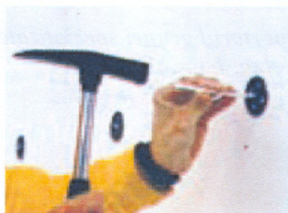
Fig.2 Schema de prindere a diblurilor (6-8buc./ mp)
