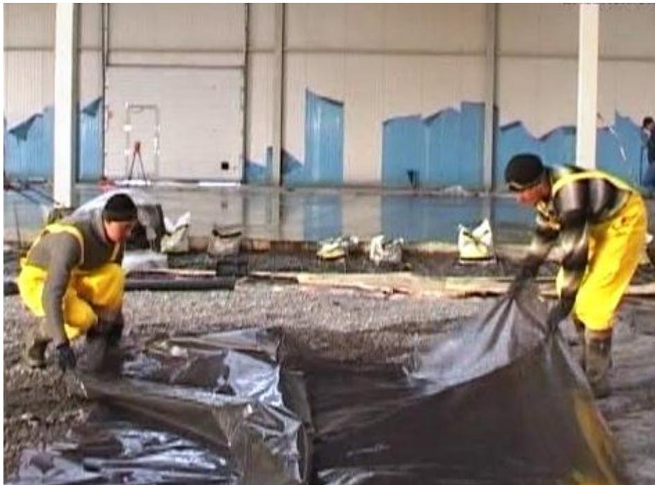
**Рисунок 2 – Устройство гидроизоляции.**
