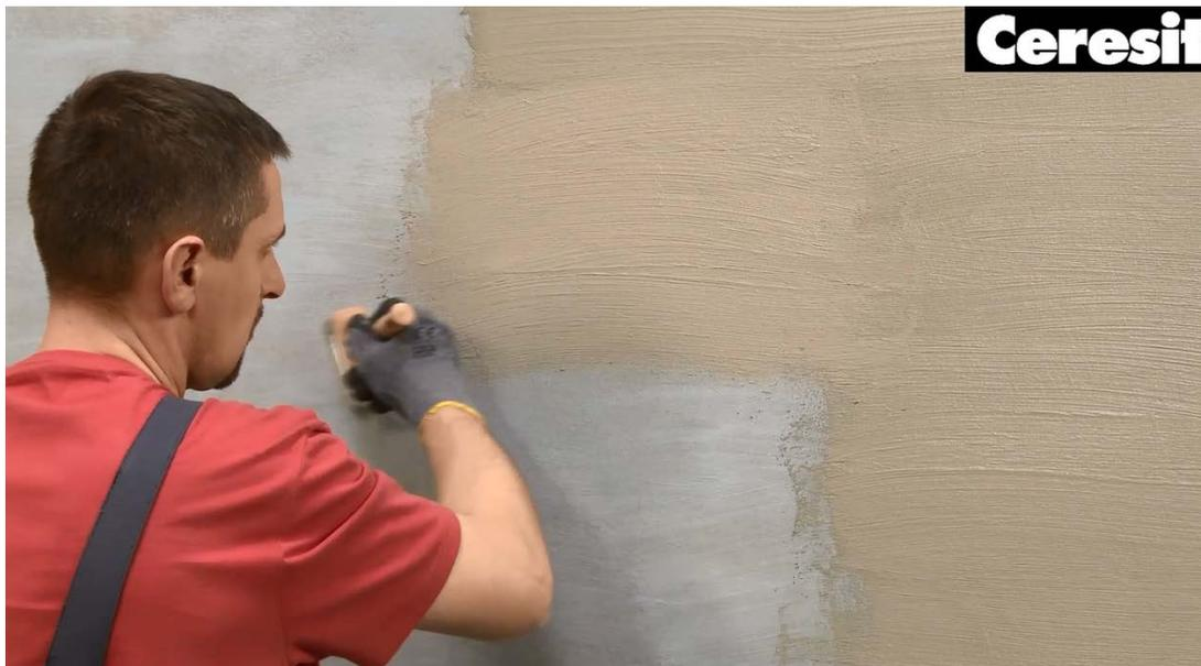
Рис. 8 Нанесение первого слоя гидроизоляции кистью.
