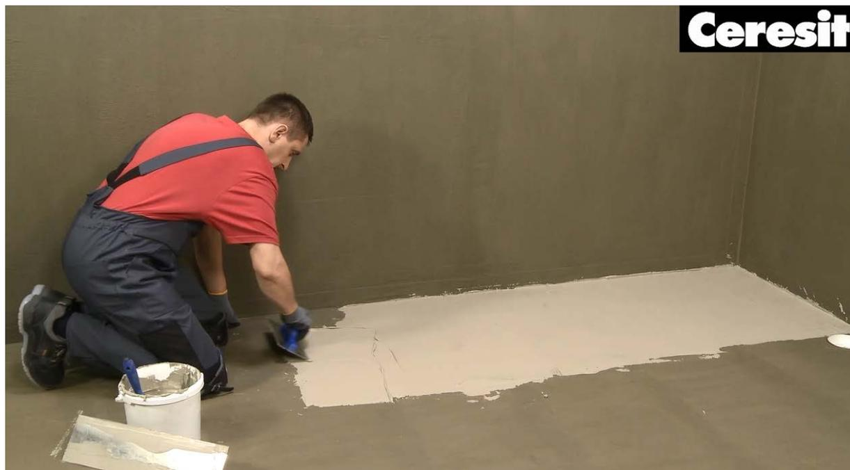
Рис. 9 Нанесение второго и третьего слоев гидроизоляции теркой
