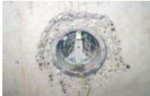
Рис. 5 Вырубка бетона по периметру оборудования
